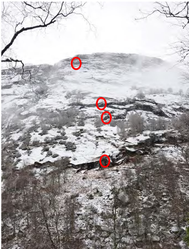
Bilde 5: Fjellsida nordaust for kraftstasjonen. Raude sirklar viser potensielle løysneområde for steinsprang.
