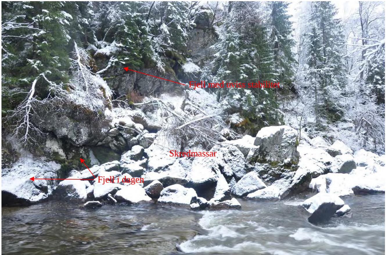
Bilde 1: Damstad, sørlege damfeste. Skredmassar over fjell.
