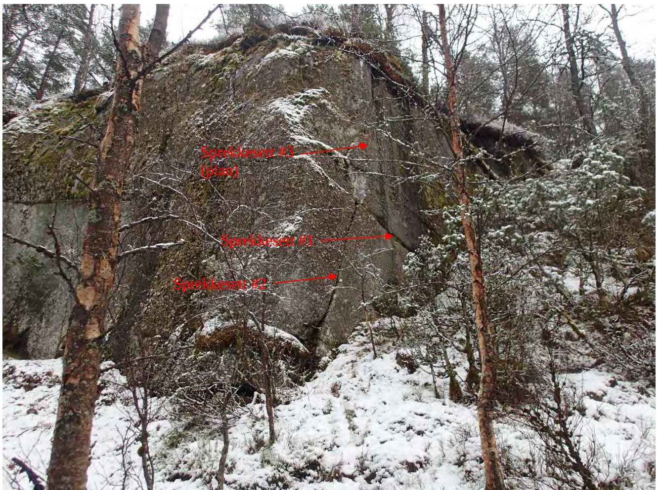
Bilde 2: Ved nedstrøms borholspåhogg. Sprekkesett er vist med piler.
