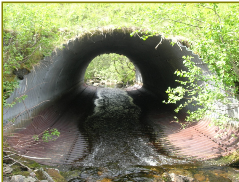
Eksisterende kulvert under E 39.
