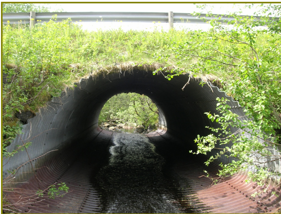
Stokkelva der den renner i kulvert under E 39.
