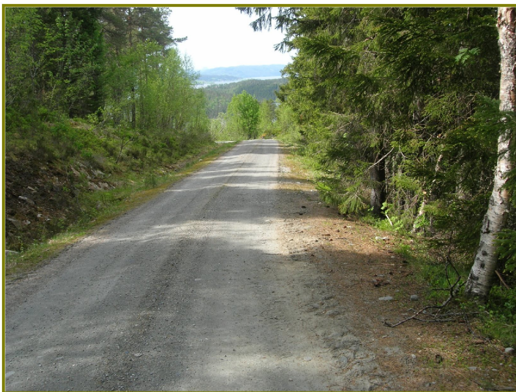
Lervik og Stokke bomvei der rørgata graves ned på høyre side av veien.
