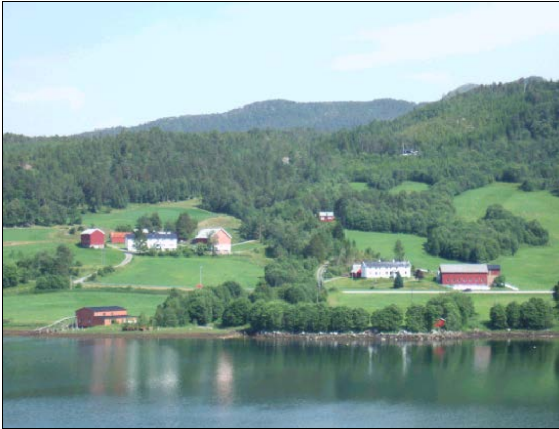
Bilde 1. Oversiktsbilde over nedre del av Stokkelva som renner midt i bildet mellom gårdene. Bildet er tatt fra Valsøya ved broen.
