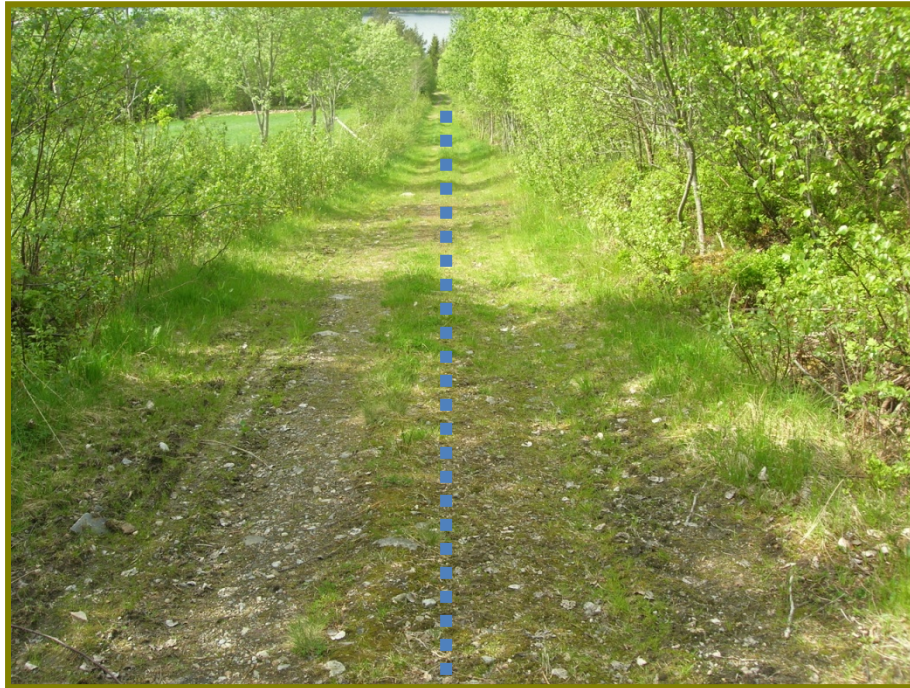
Fra kote ca. 80 til kote 15 graves rørgata ned i traktorvegen.
