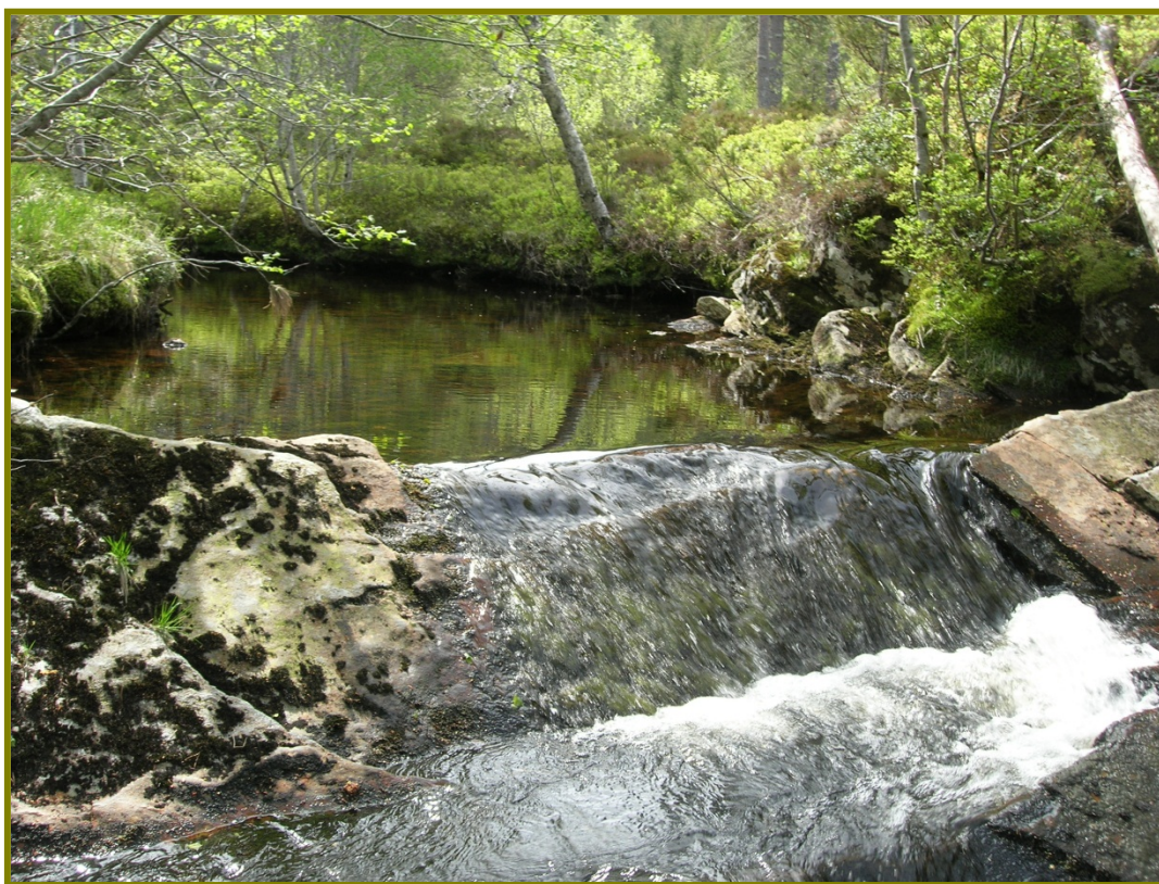
Her bygges det en sperredam på ca 1,5 meter.
