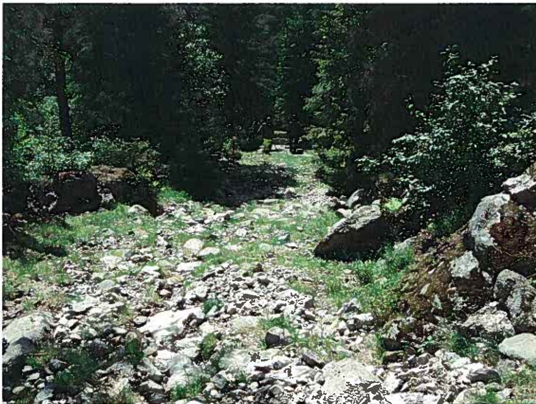
Bilde 5: Rørtrace i gammel stølsvei, oppstrøms vannverket
