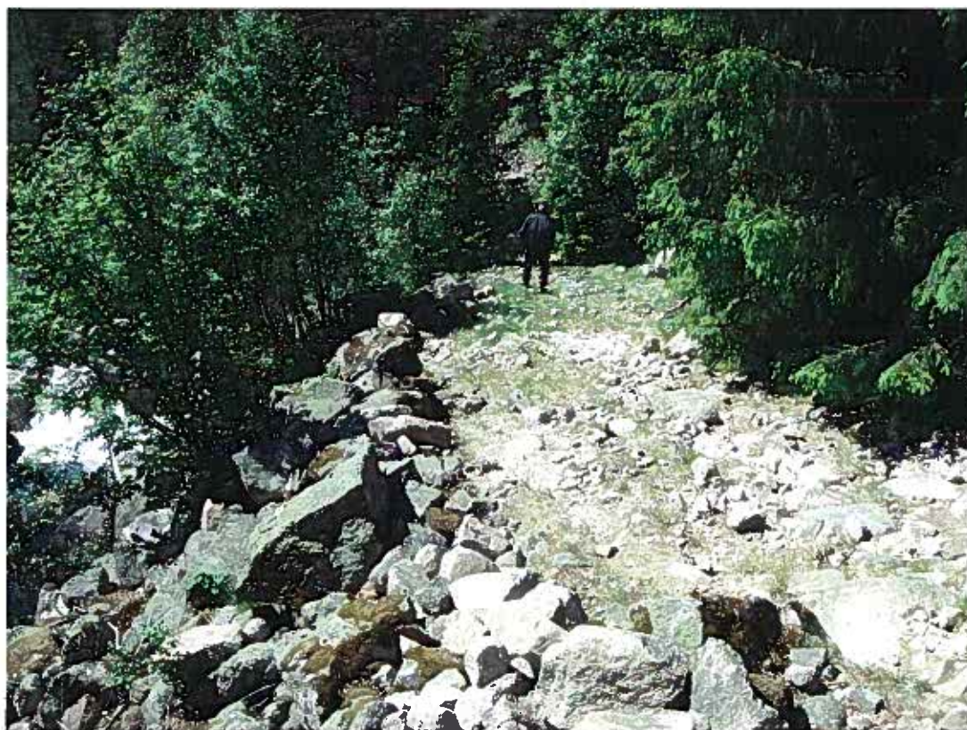
Bilde 4: Rørtrace i gammel stølsvei, nedstrøms samløp bekker.
