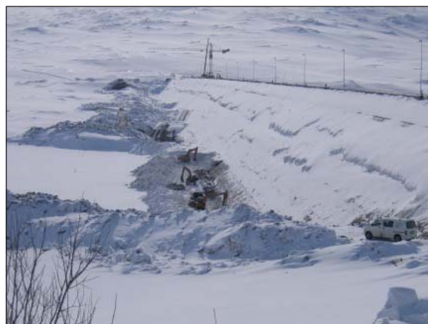
Figur 7.2. Utbedringene på dammen er i full gang den 21. mars 2006. Foto: Espen Finstad, OFK.
