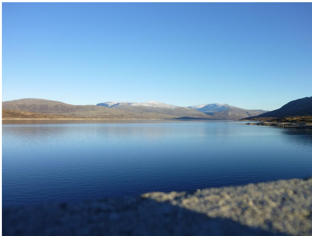
Figur. Aursjømagasinet sett fra Aursjødammen. 11.10.2016. Foto: NVE
