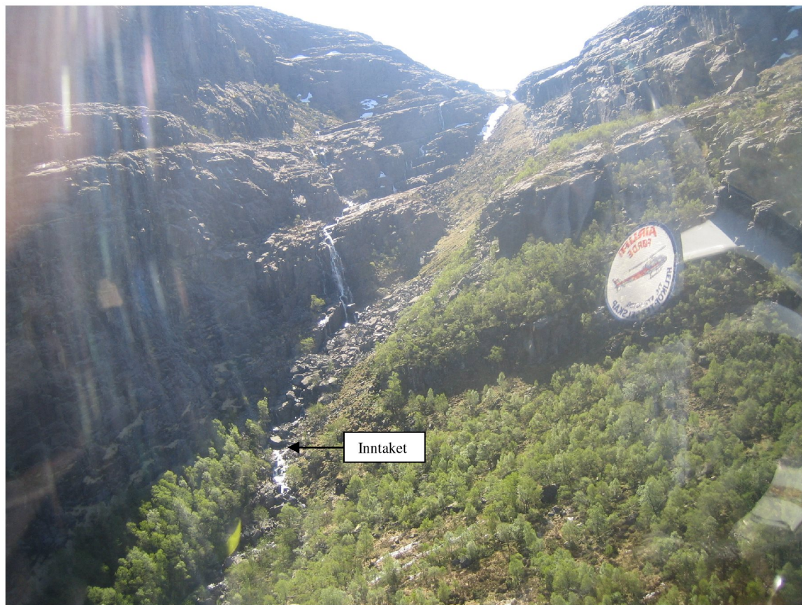
Figur 2 Inntaksområdet og øvre del av rørgatetraséen
