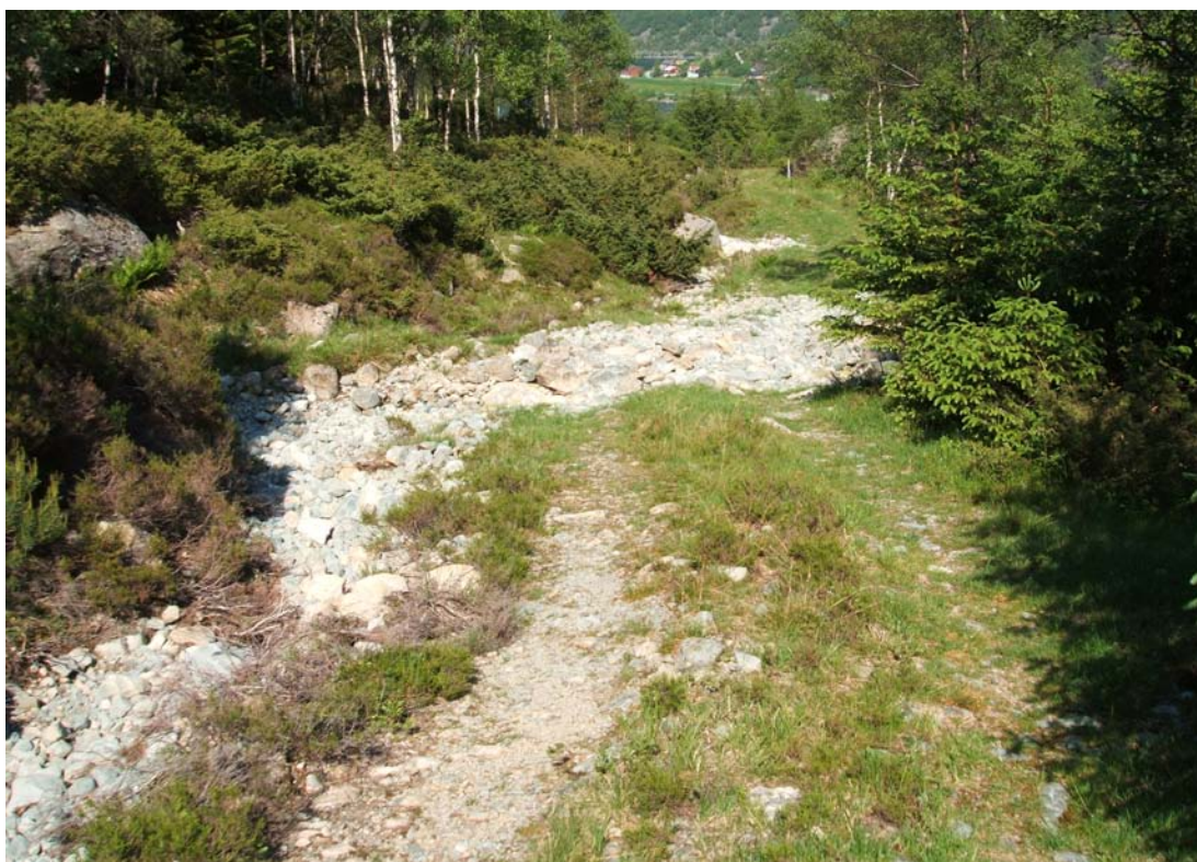
Skogsvegen der rørgata vil ligge en stor del av lengden
