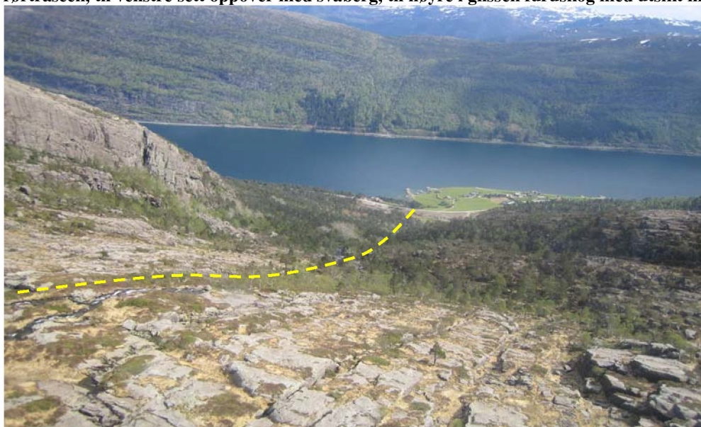
Utsikt over rørtraséen mot fjorden
