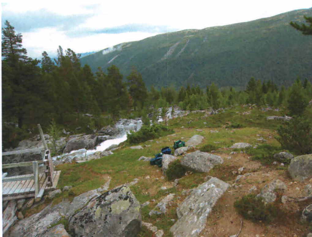
Bilde 5: Sett nedover Stamåe og rørtrasé fra ca kote 780.
