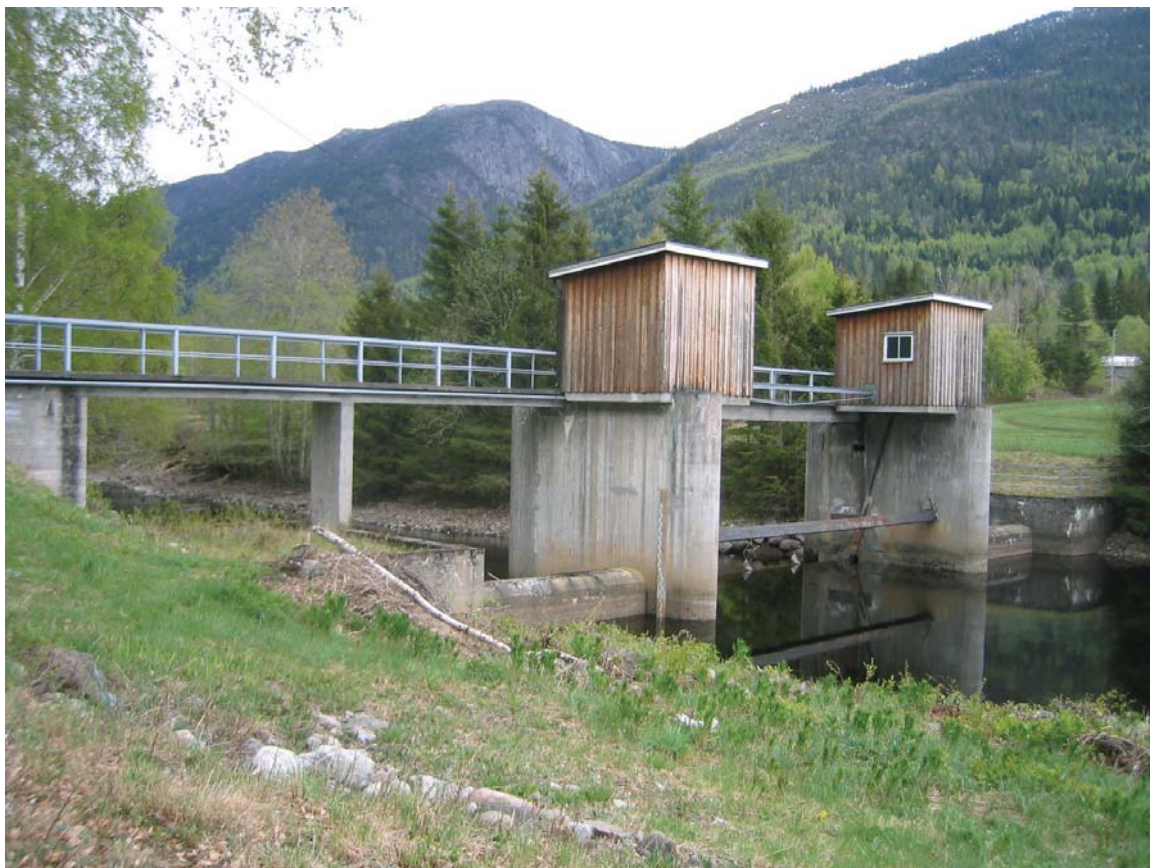
Figur 3-14 Eksisterende dam Hjartsjø bygges om til ren betong overløpsterskel
