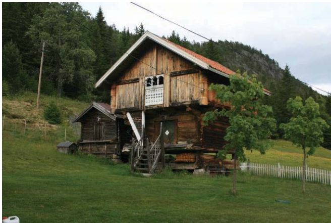
Figur 7-38 Automatisk fredet loft på Skårdal. Bilde: Mortensen, 2008.
