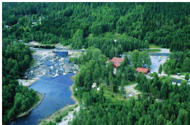
Figur 7-63 Fossen Kro & Motell til høyre. E134 krysser elva over brua. Bilde: Skagerak Kraft.
