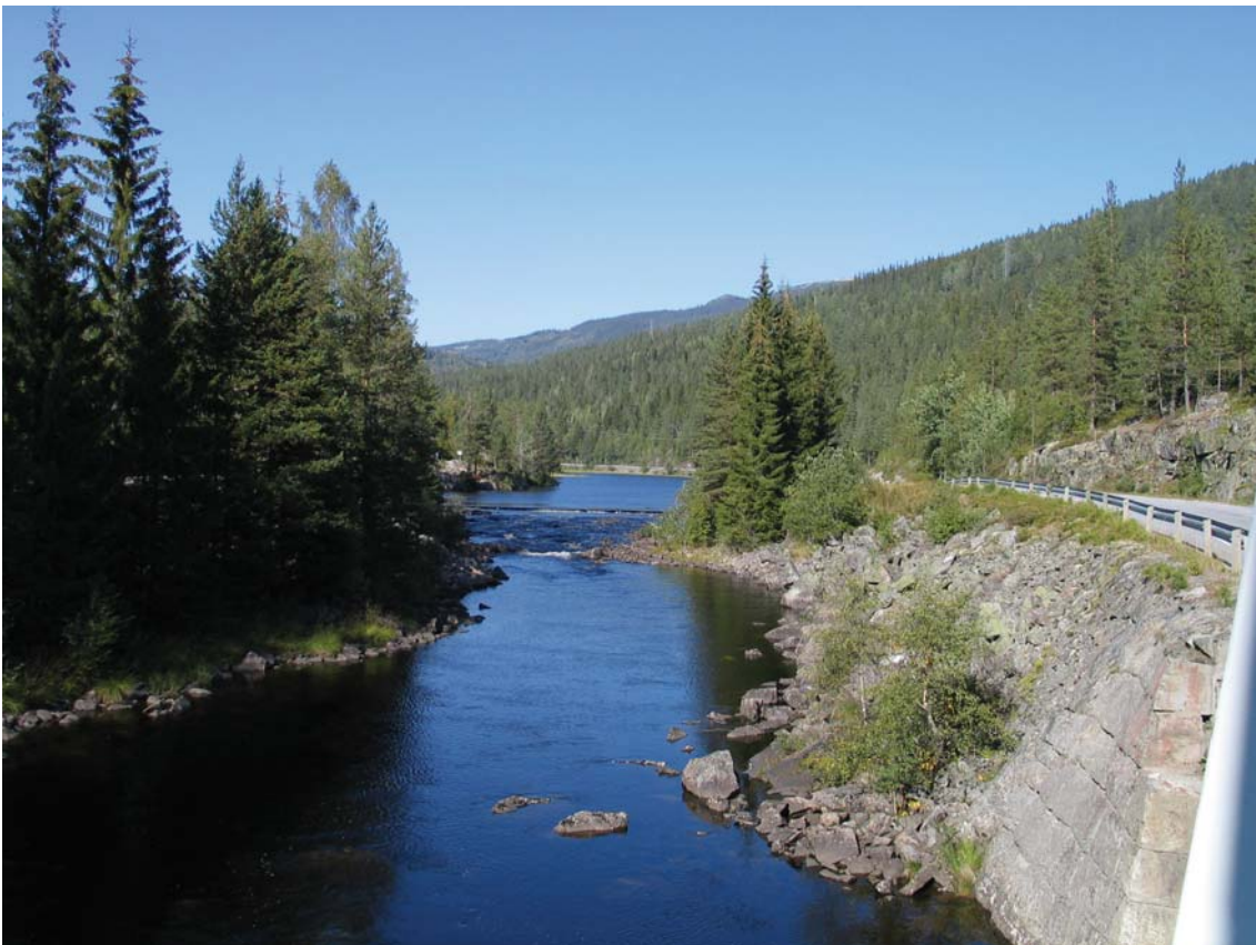
Figur 3-16 Eksisterende terskel Sønderlandsvatn (rives/flyttes)
