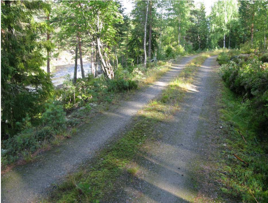
Figur 4.9. Skogsvei nord for Elgevad. (Foto: Rune Idsøe).
