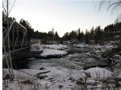
Figur 7-3 Bildet viser vannføring på 5,5 m 3 /s. Dette er representativt for middelvannføring etter utbygging, iflg Lancaster 2008:VIII (Foto: Skagerak Kraft)
