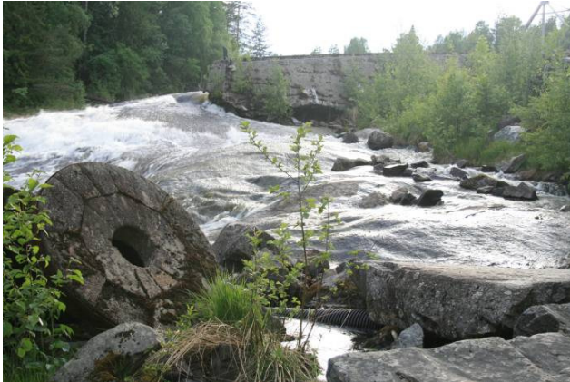
Figur 1-1 Nedstrøms Omnesfossen (foto: Mona Mortensen, SWECO)
