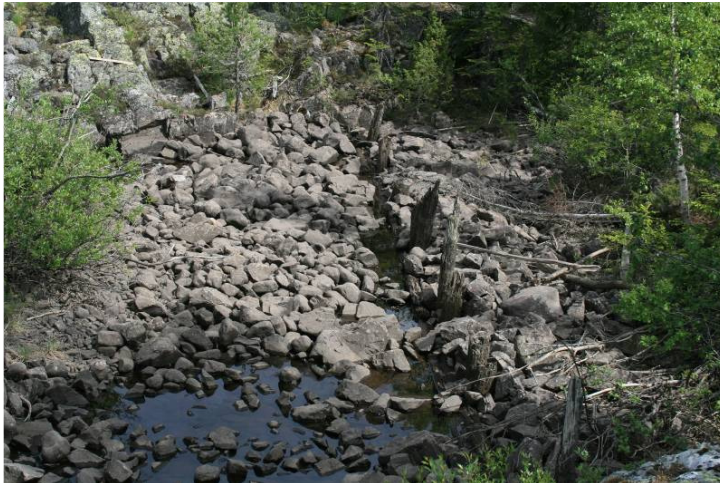
Figur 6-3 Rester etter elveforbygning ved utløpet av Sønderlandsvatn (Foto: Mona Mortensen, SWECO)
