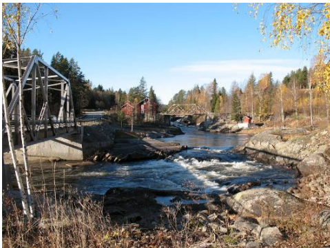
Figur 7-3 Bildet viser vannføring forbi Heddal mølle på 11,5 m 3 /s. (Foto: Skagerak Kraft)
