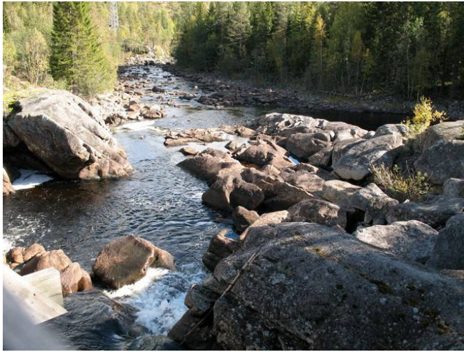
Bilde 8-1: Skogsåa ved Koparviken nedstrøms brua 17.09.07. Vannføringen på bildet er 0,57 \text{ m}^3/\text{s} . Dette tilsvarer noe under median vannføring etter utbygging (Foto: Skagerak Kraft AS).
