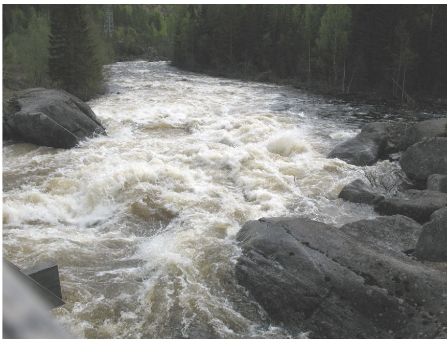
Bilde 7-5: Vannføring på bildet er 28,7 m 3 /s. Vårflom i mai 2008. (Foto: Skagerak Kraft AS)
