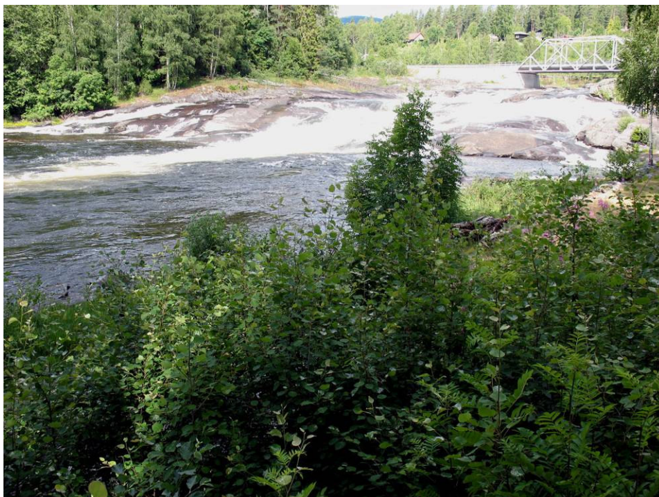
Bilde 7-20: Omnesfossen med vannføring 24,7 m 3 /s, juli 2008. Dette tilsvarer dagens middelvannføring (23,0 m 3 /s ved Omnesfossen (Lancaster, 2008) (Foto: Skagerak Kraft AS)
