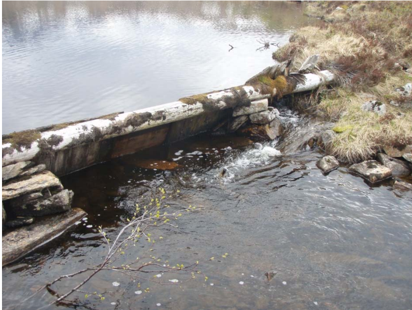
Bildeserie 3, foto 1. Demning på utløp Storlivatn. Legg merke hullet i demningen til høyre i bildet som sikrer passasje for fisk, WP 037.
