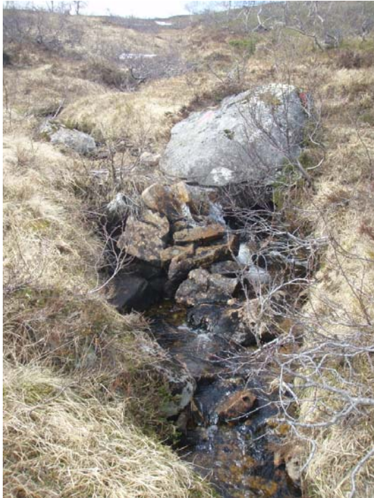
Bildeserie 3, foto 4. Vandringsstopp for fisk i tilløpsbekk til Storlivatn, vestre løp WP 029. Vandringshindret er like nedstrøms turstien.
