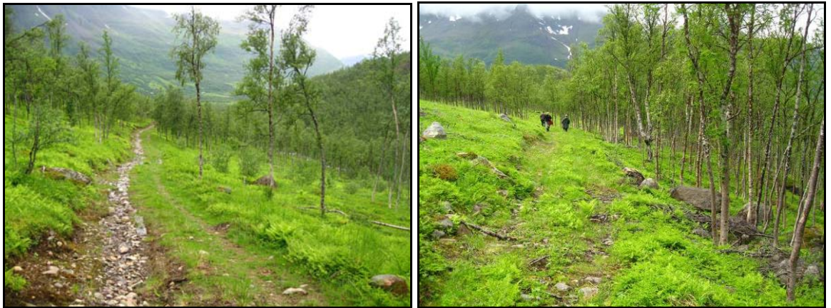
Figur 9 Eksisterende traktorvei. Venstre: ca. midtveis i rørtrasé. Høyre: øverste del av traktorvei 600 – 700 m nedstrøms inntaket. Rørtraseen vil følge traktorveien.
