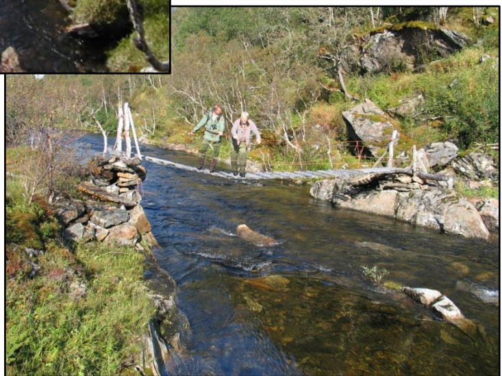
Figur 3 Hengebro over elva i området ovenfor inntaket.
