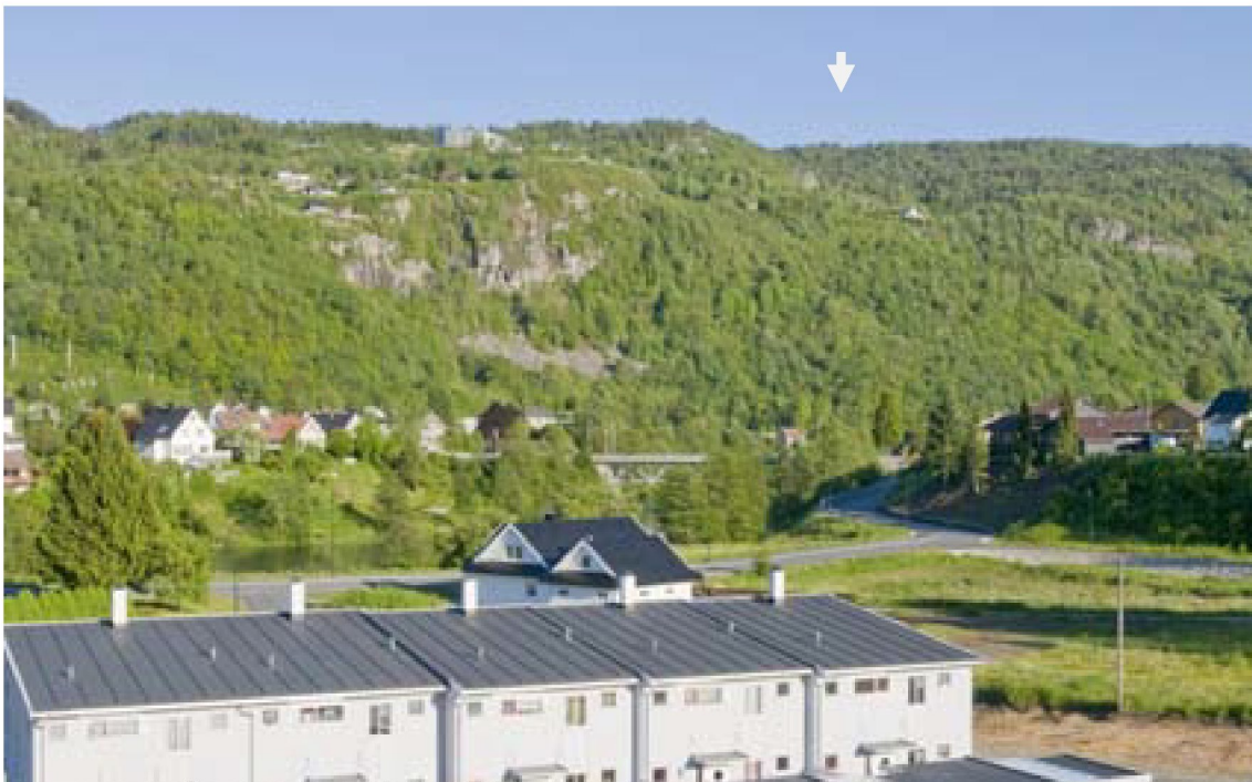
Figur 11: Kvinesheia vindpark (Slettheia og Storhei) sett fra Kvinesdal VGS ved ikke omsøkt utbygging (117 MW). Én turbin (ca. 2,6 km unna) er synlig (angitt med hvit pil). Foto og visualisering: Einar Berg
