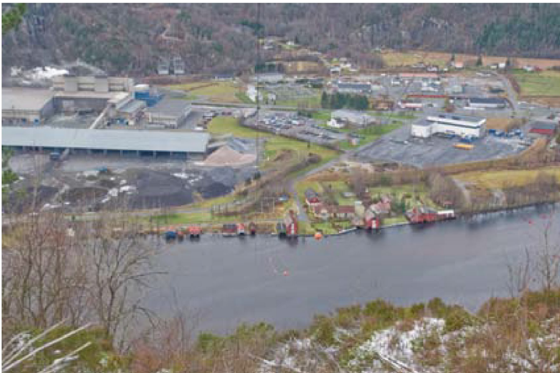
Figur 33: Øyestranda, dagens situasjon med innmating av flere ledninger kloss innpå den intime bebyggelsen i strandsonen.
