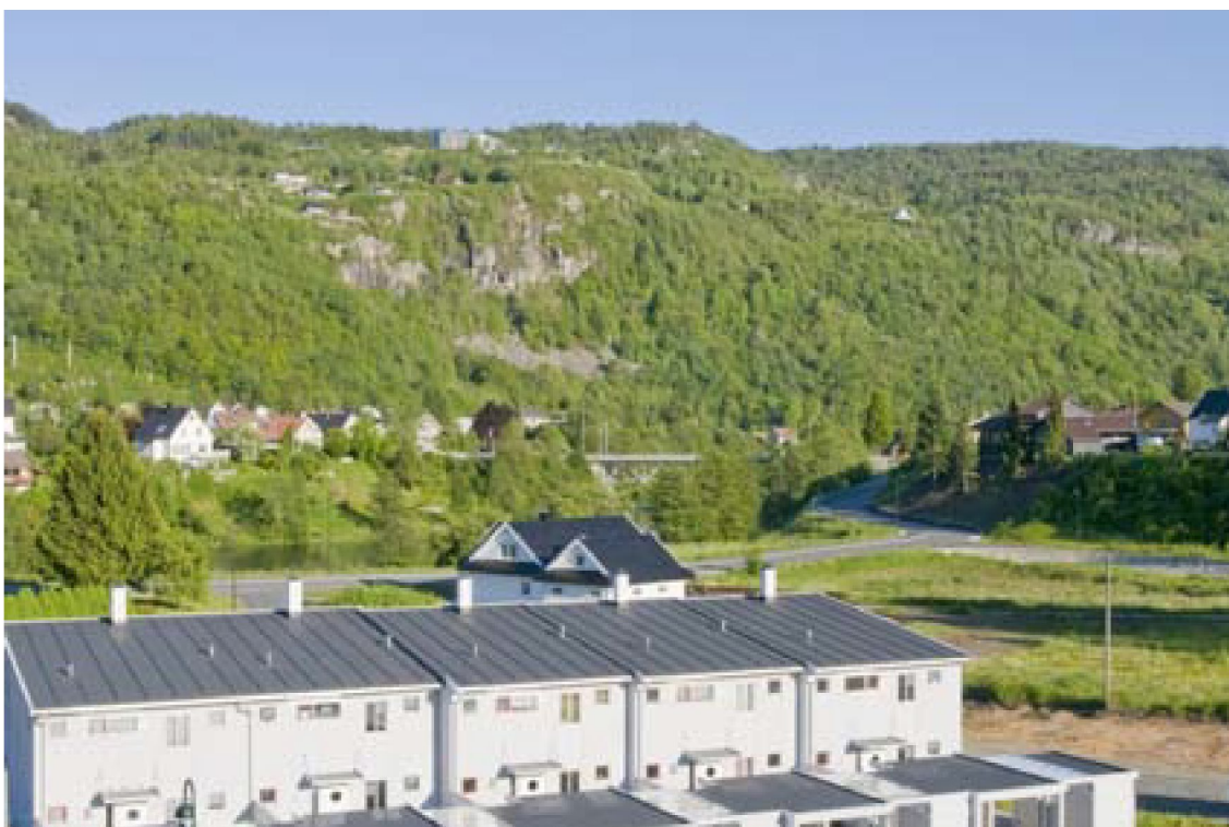
Figur 23: Kvinesdal VGS, omsøkt utbygging (60 MW). Ingen turbiner blir synlige. Foto: Einar Berg
