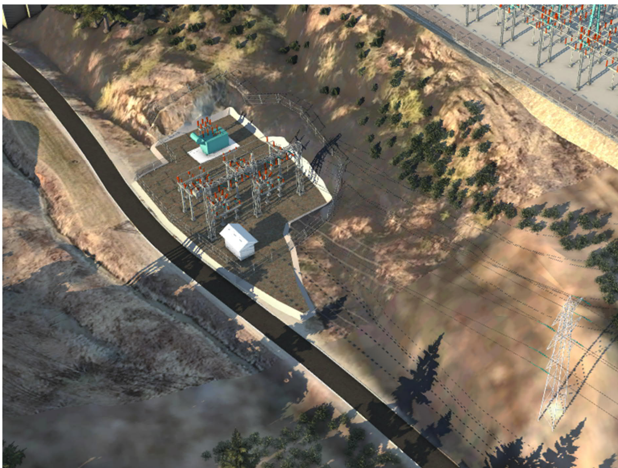
Figur 5 Kaggefoss transformatorstasjon. Omsøkte tiltak er beskrevet i søknaden.
