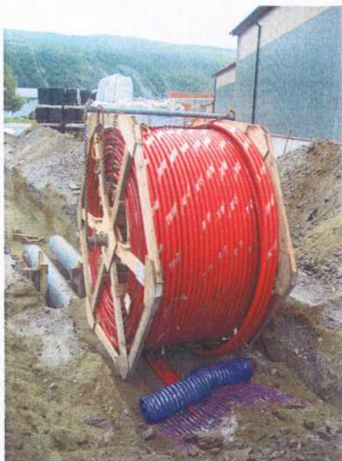
Figur 4-9: Sammen med fjernvarmerørene legges 3 trekkør. Markeringsbånd merker hvor fjernvarmerørene ligger.
