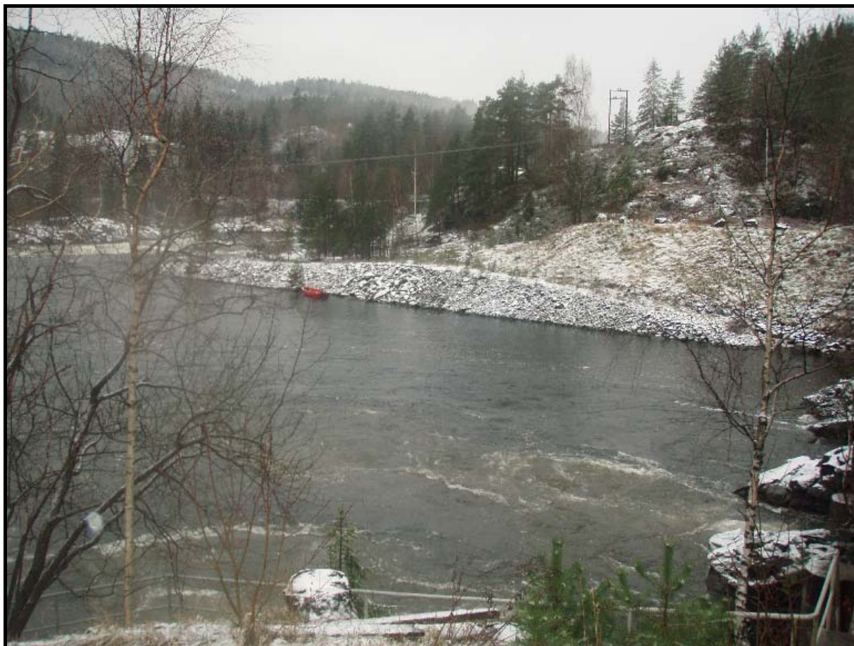
Figur 6 Utløpet av eksisterende Iveland kraftverk
