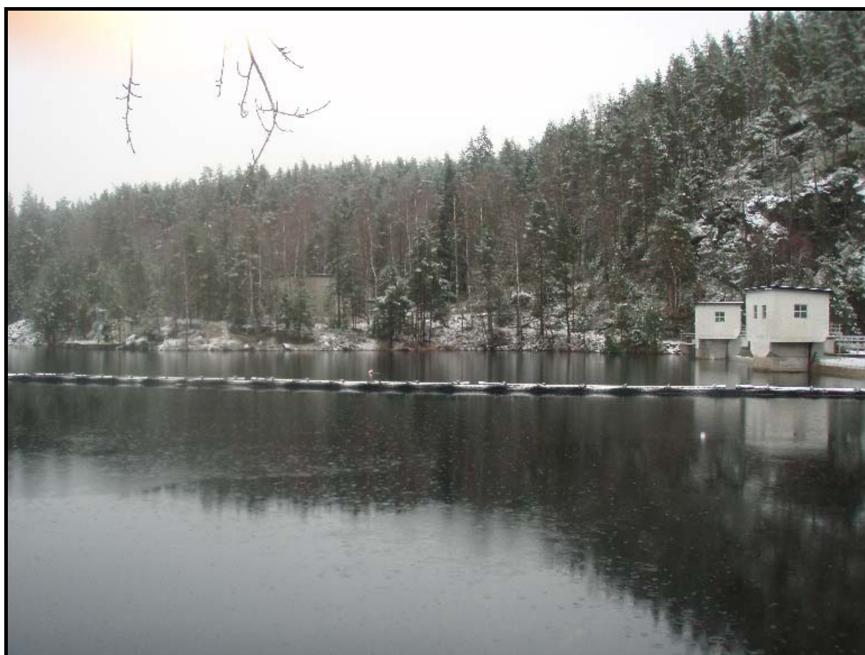
Figur 3 Eksisterende inntak til Iveland kraftverk i Gåseflåfjorden.
