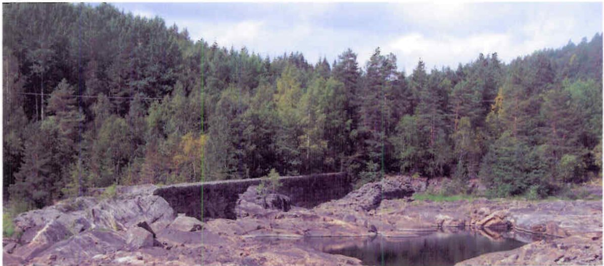
Foto 2: Flere generasjoner elveforstøtninger på vestbredden av Otra, område B.
