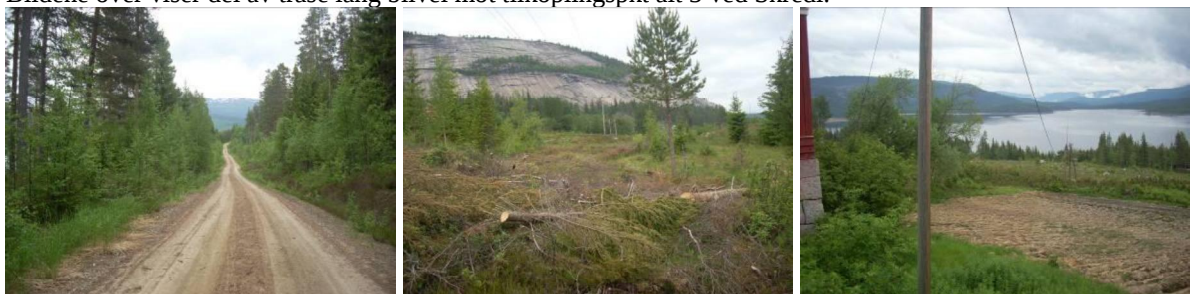
Bildene over viser del av trase mot sørøst, tilkoplingspkt 3 sett fra bilvei i midten og fra tunet på Skredi til høyre.
