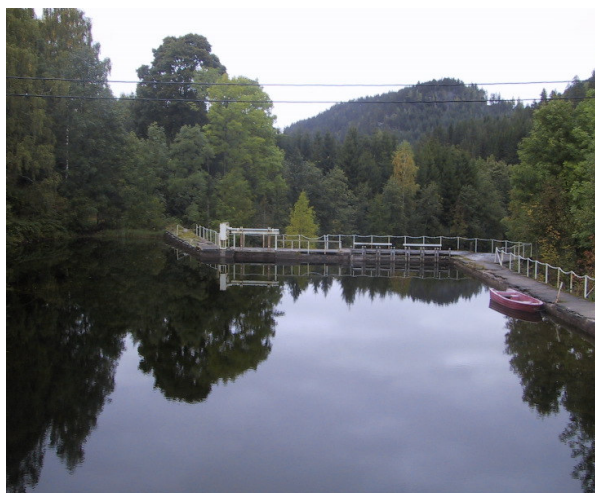
Dam sett oppstrøms fra veibru
