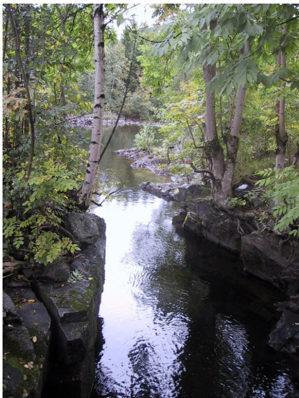
Utløpskanal fra senkningstunnel
