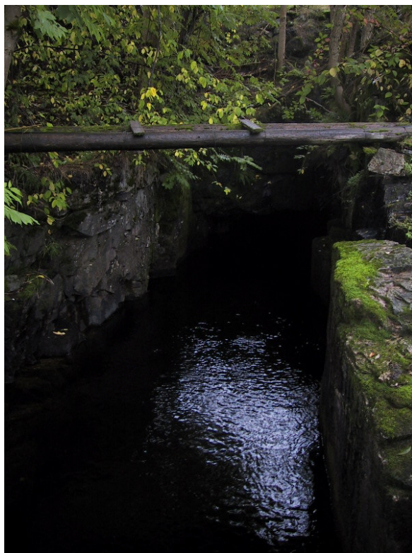
Utløpskanal sett inn mot munning av senkningstunnel
