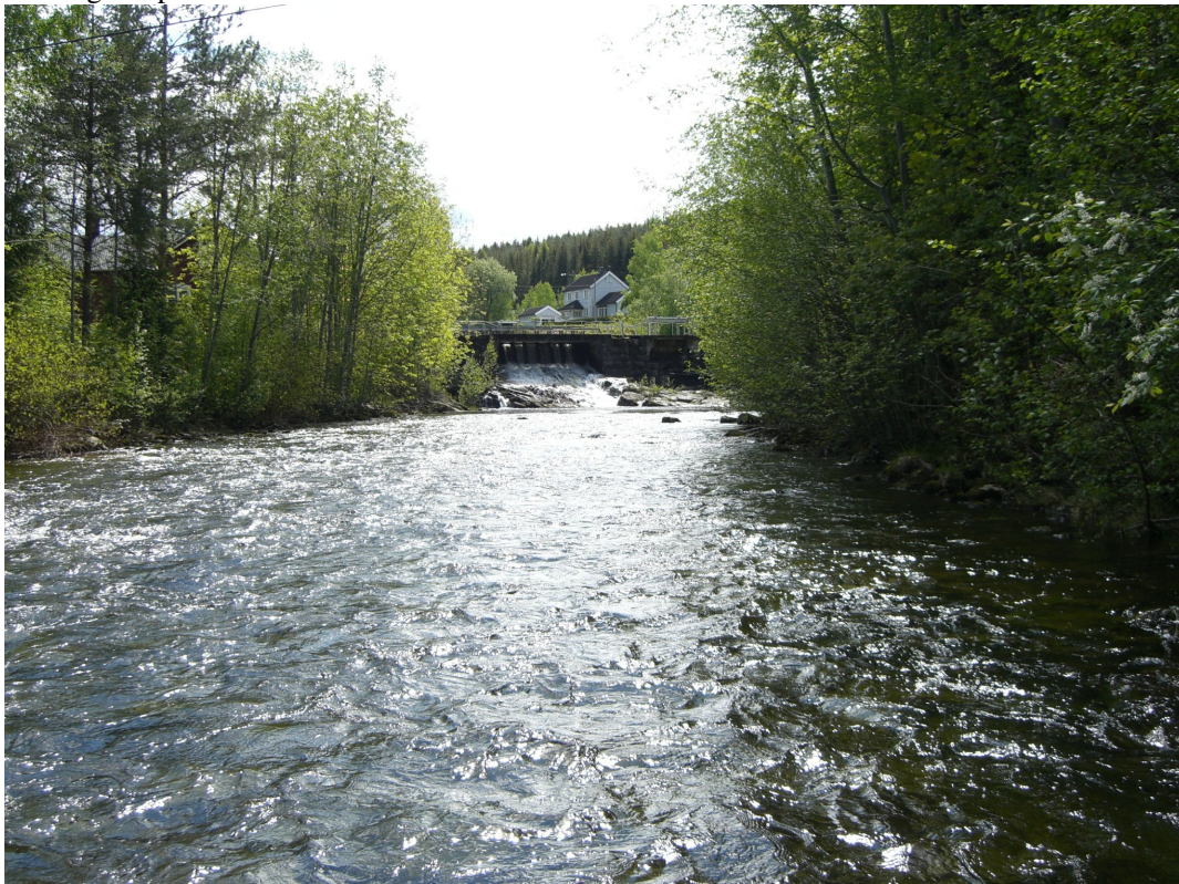
Elveløpet nedstrøms senkningstunnelen
