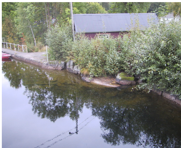
Dam sett oppstrøms fra veibru
