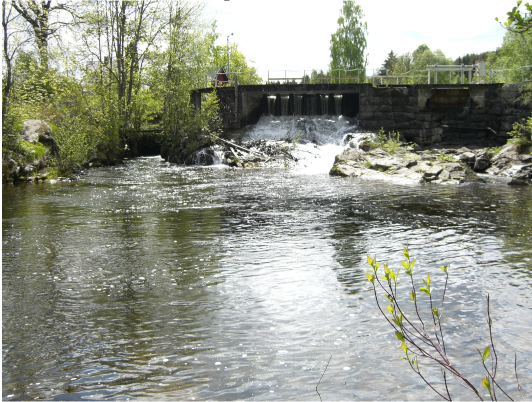
Dam og utløpskanal
