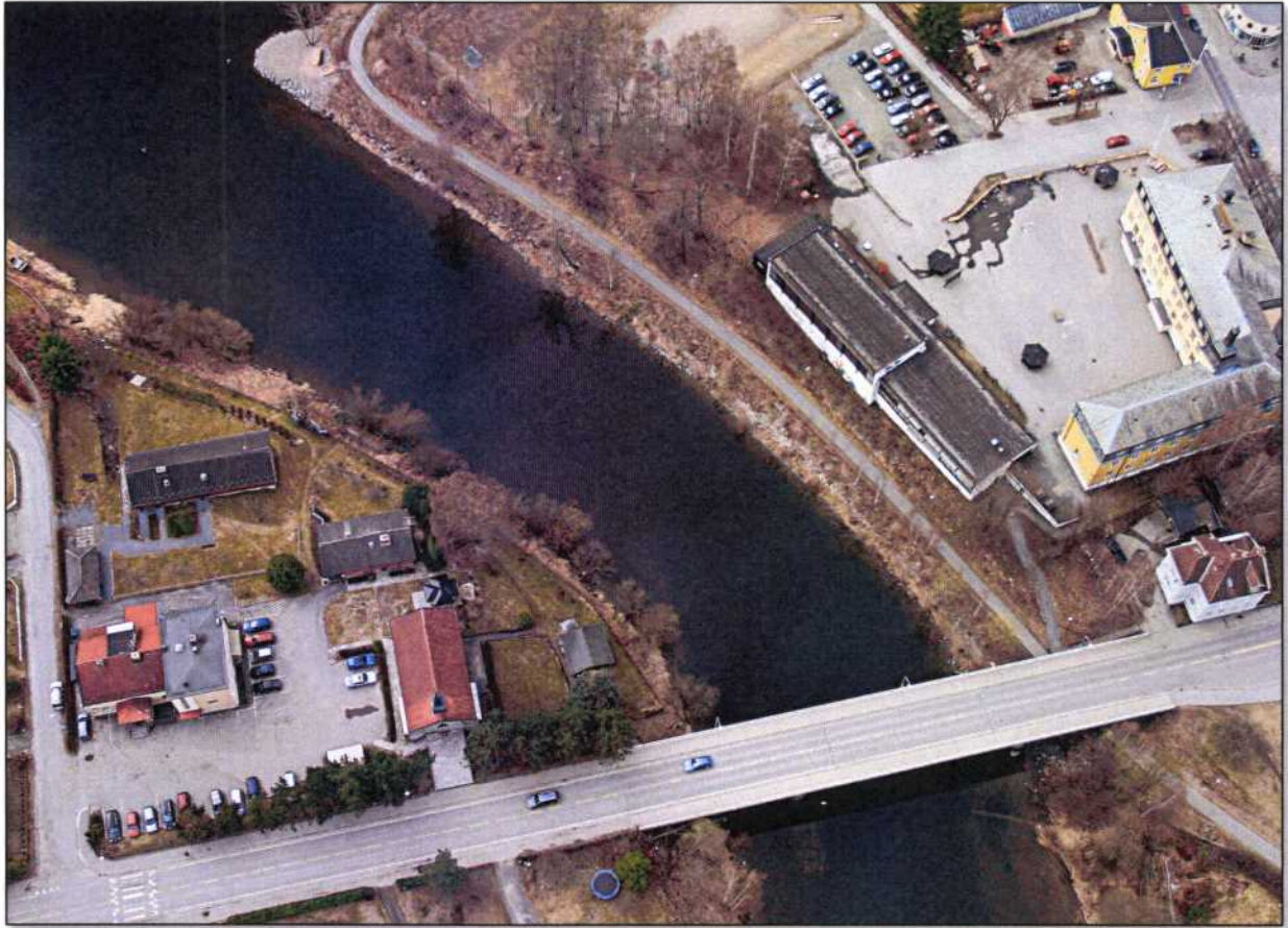
Bilde 14(2) tatt 20. april 2010 der Randselva løper sammen med Begna, ca. 9 km nedenfor Viul kraftverk, ved en vannføring på 18 \text{ m}^3/\text{s} , som ble benyttet til å vurdere vanndekket areal.
