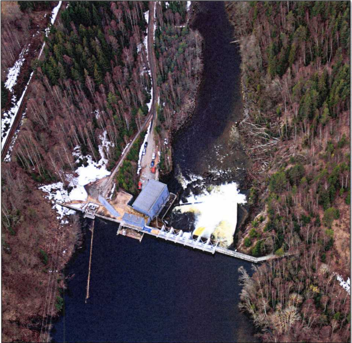
Bilde 1(3) tatt 20. april 2009 ved Viul kraftverk med en vannføring på 13 m 3 /s, som ble benyttet til å vurdere vanndekket areal.
