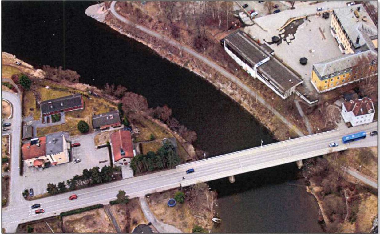
Bilde 14(3) tatt 20. april 2009 der Randselva løper sammen med Begna, ca. 9 km nedenfor Viul kraftverk, ved en vannføring på 13 \text{ m}^3/\text{s} , som ble benyttet til å vurdere vanndekket areal.
