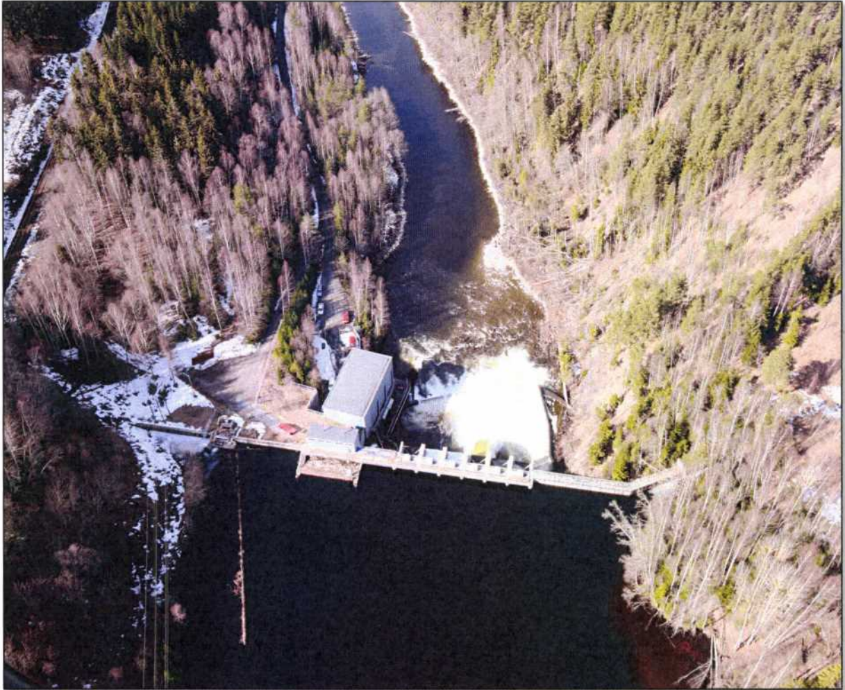
Bilde 1(2) tatt 20. april 2010 ved Viul kraftverk med en vannføring på 18 \text{ m}^3/\text{s} , som ble benyttet til å vurdere vanndekket areal.
