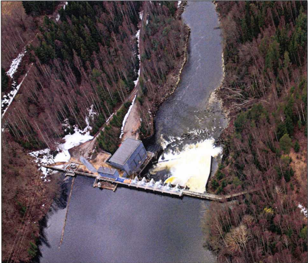
Bilde 1(1) tatt 20. april 2009 ved Viul kraftverk med en vannføring på 20 m 3 /s, som ble benyttet til å vurdere vanndekket areal.
