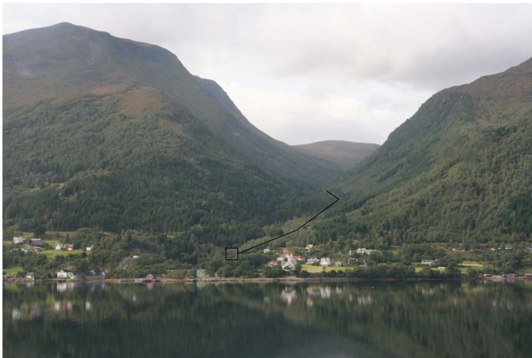
Dravlausgrenda sett frå Dalsfjorden. Kraftstasjons plasseringa er merka med firkant og tilløpsrøret med strek.
