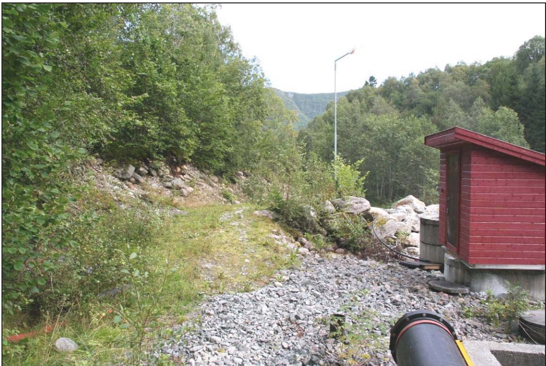
Figur 6. Kraftstasjonen er planlagt ved eksisterende inntaksbasseng for settefiskanlegget, ca. kote 20 (foto 4. september 2007: Ole Kristian Spikkeland).
