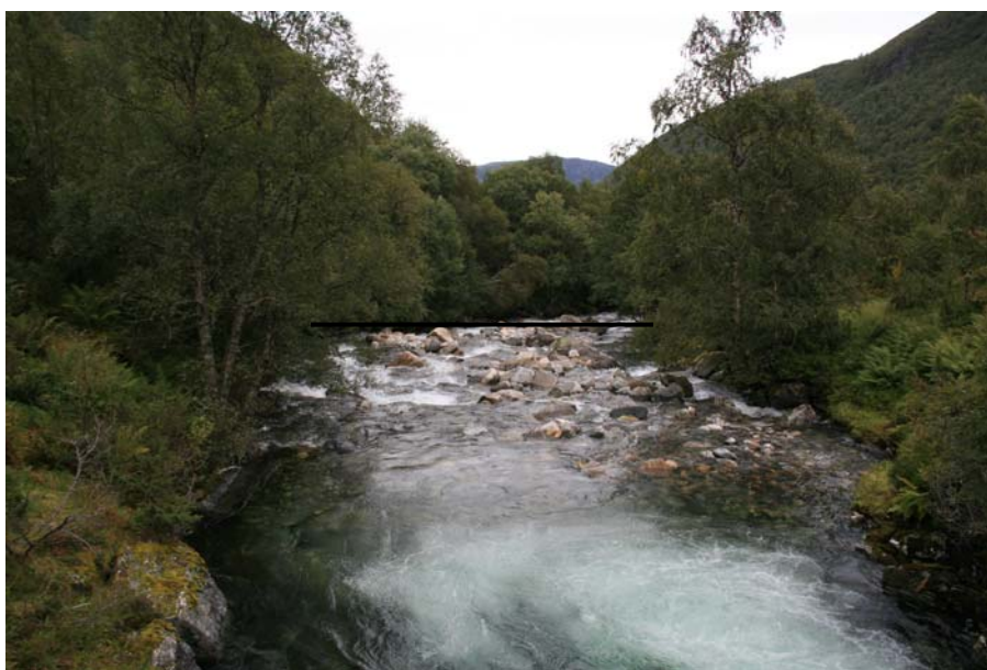
Stad for inntak sett frå stølsbrua. Streken angir inntaksterskelen over elva. Vasstanden i bruahølen i framgrunnen blir ikkje berørt.
