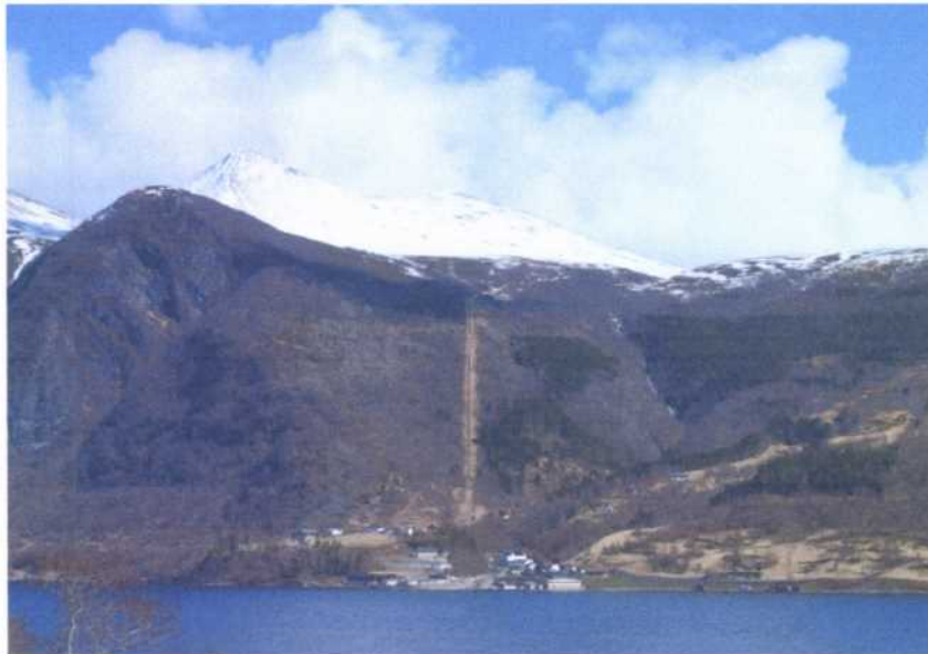
Dale kraftverk vart sett i drift i 1990.
