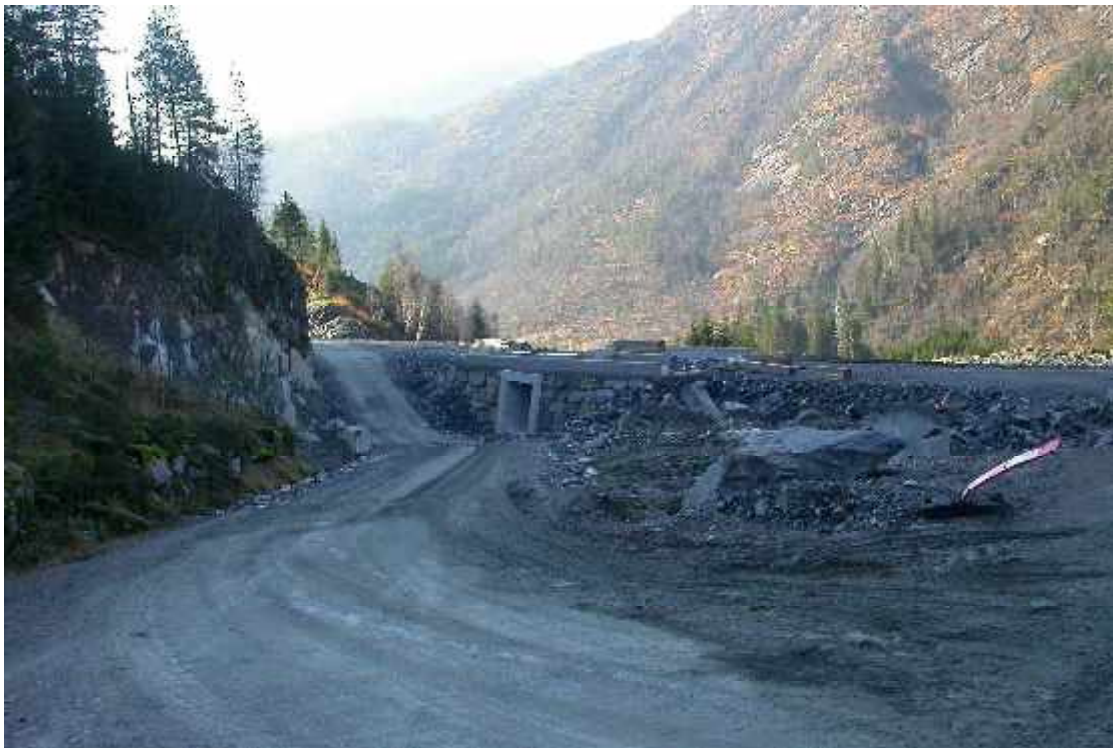
Figur 6. Her ser ein litt av den nye E39 som er under bygging gjennom Romarheimsdalen. Som ein ser er det laga ein undergang for tilkomst til gardbruket Nipa, som ligg nede i dalbotnen. (Foto; Finn Gunnar Oldervik ©)
