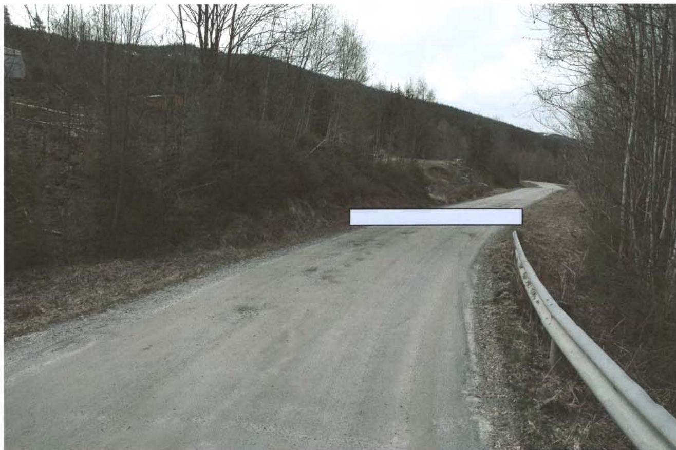
Rørgate-kryssing av Strandalivegen. Ca 150 m ovenfor kraftstasjonen. 19.05.10.
