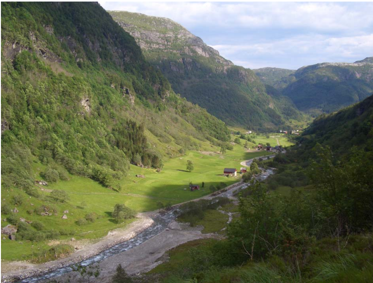
Elveforbygging etter utbedring våren 2007 Utsikt nedover dalen.
