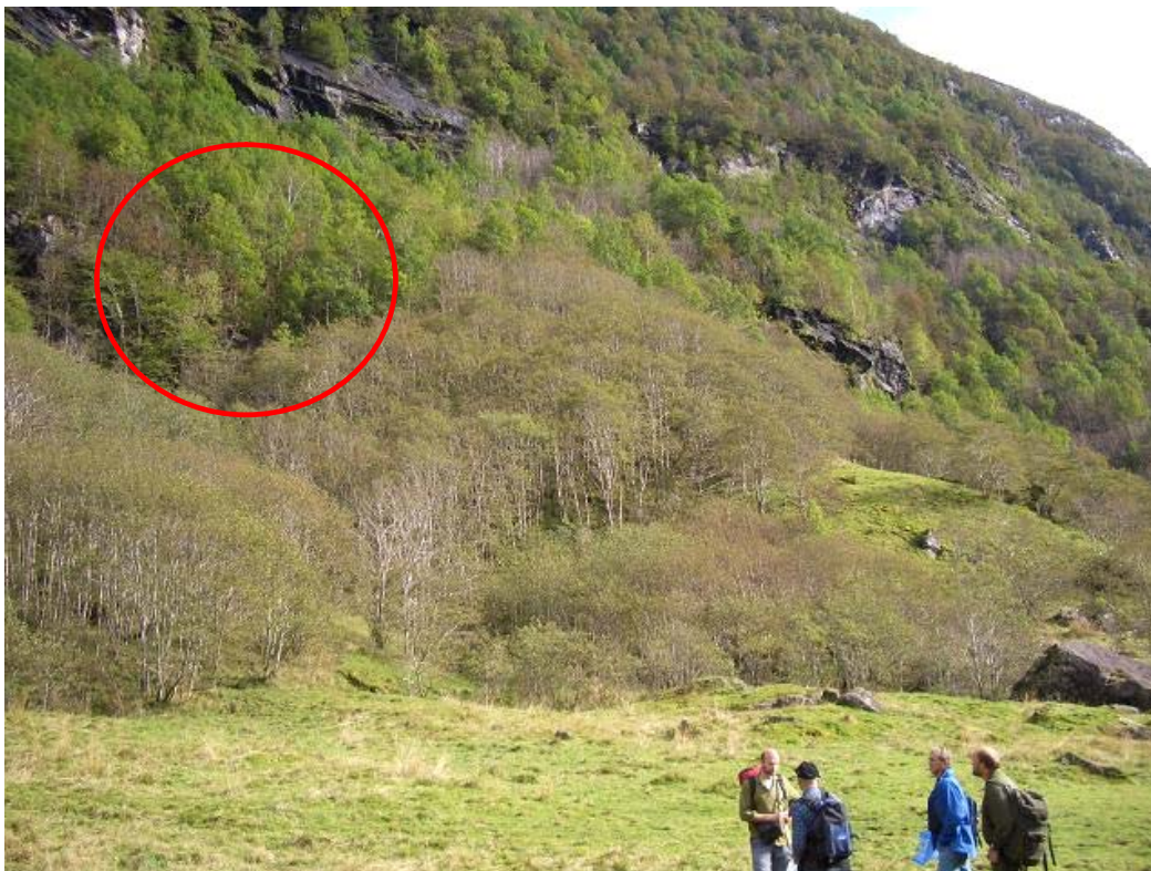
Rød sirkel viser planlagt plassering av påhugg for tunnel. Dimensjon og farge på symbolet er tilfeldig. Fra påhugget vil det gå rør i grøft ned til kraftstasjonen.
