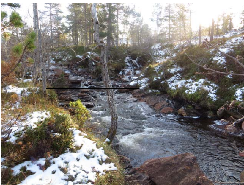
Stad for inntak sett oppstrøms. Streken angir toppen på inntaksterskelen over elva.
