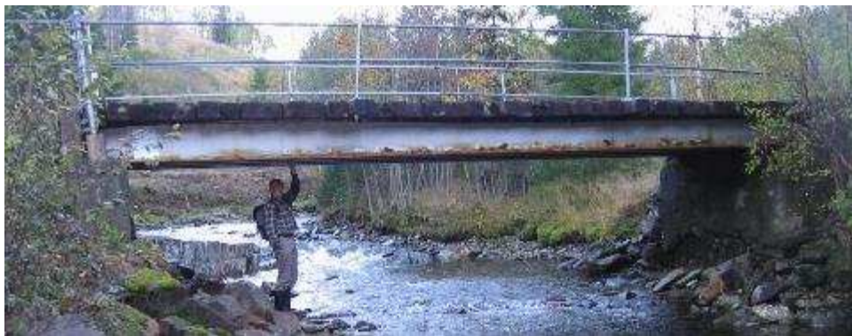
Figur 11: Eksisterende bro over elven som må benyttes for adkomst til stasjon og anleggsområde
