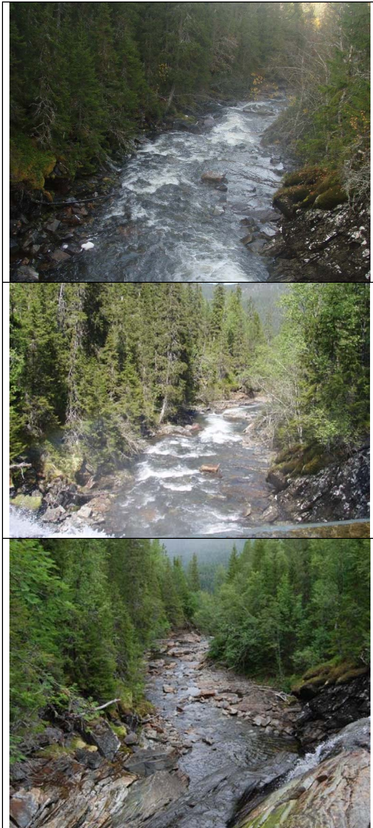
Figur 17 Fra utbyggingsstrekningen i Gudåa. Forskjellen i vannføringen på de to øverste bildene tilsvarer om lag 1,9 \text{ m}^3/\text{s} ( 1,4 \text{ m}^3/\text{s} øverst og 3,3 \text{ m}^3/\text{s} midten). Dette illustrerer derfor tilnærmet en situasjon med full drift i kraftverket. På det nederste bildet er vannføringen ca. 0,12 \text{ m}^3/\text{s} , og dette tilsvarer derfor tilnærmet en situasjon med middelvannføring fra restfeltet ( 0,09 \text{ m}^3/\text{s} ) og sommerminstevannføring fra inntaket ( 0,03 \text{ m}^3/\text{s} ).
