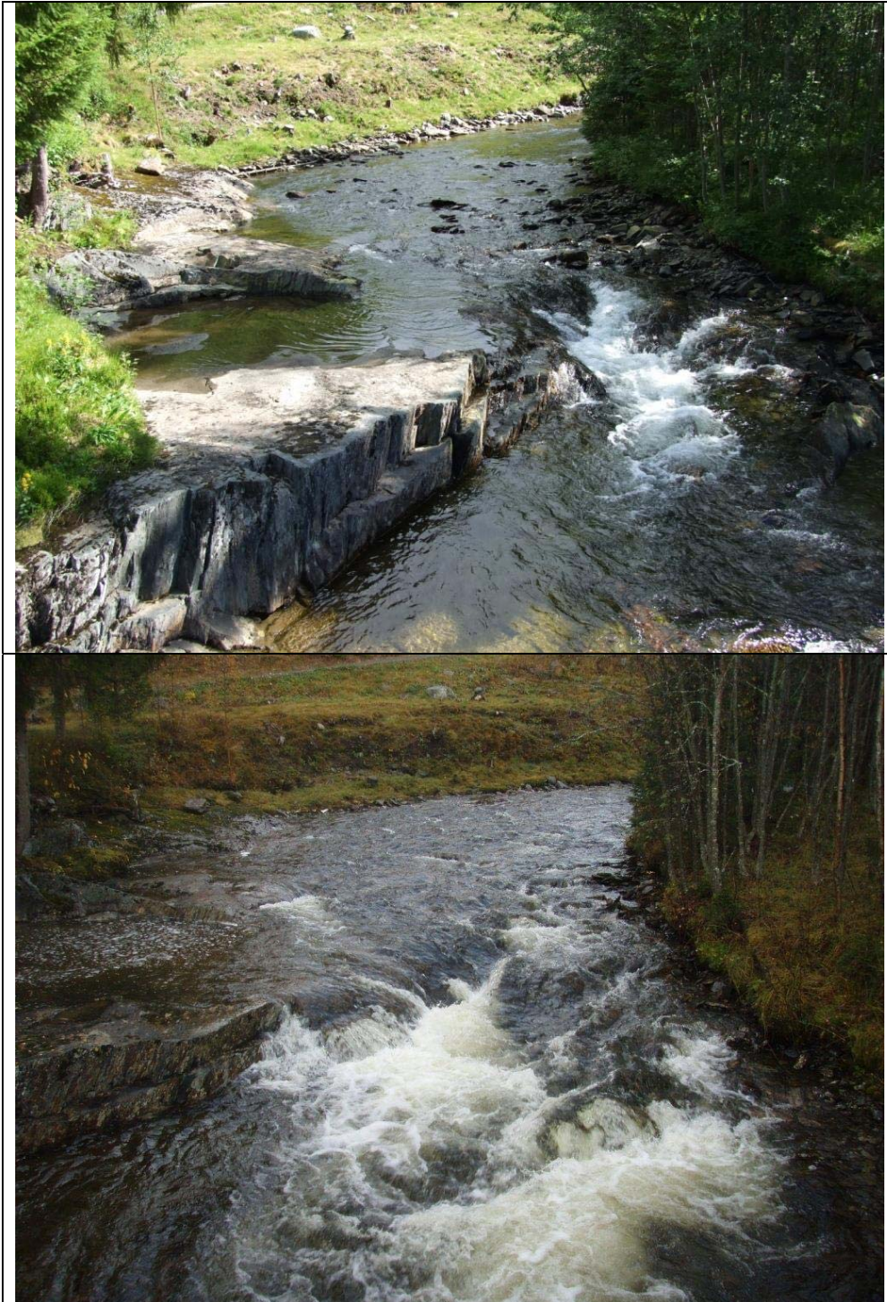
Figur 18 Like oppstrøms planlagt kraftstasjon i Gudåa. Vannføringen er hhv. ca. 0,7 m 3 /s (øverst) og 1,4 m 3 /s (nederst).
