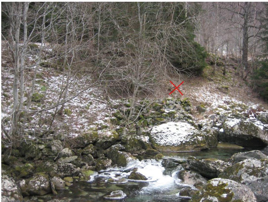
Bilde 11: Kraftstasjonsområdet, øvre, på elvas østside, sett fra vest.
