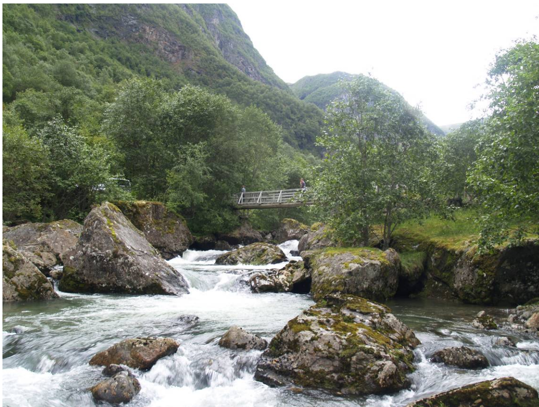
Bilde 3: Gangbru over elva, ca. 500 m oppstrøms inntak.
