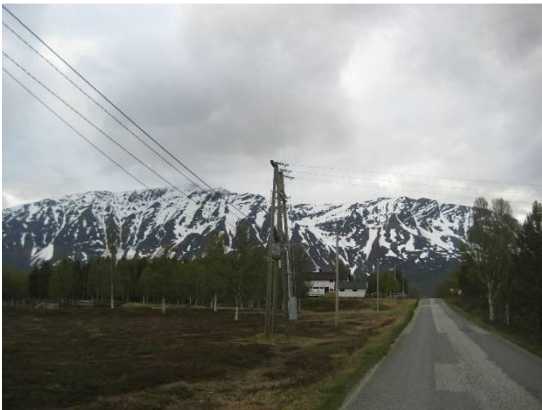
Bilde 8: Kraftlinje og kommunal vei ved Hornset. Foto: Elvekraft
