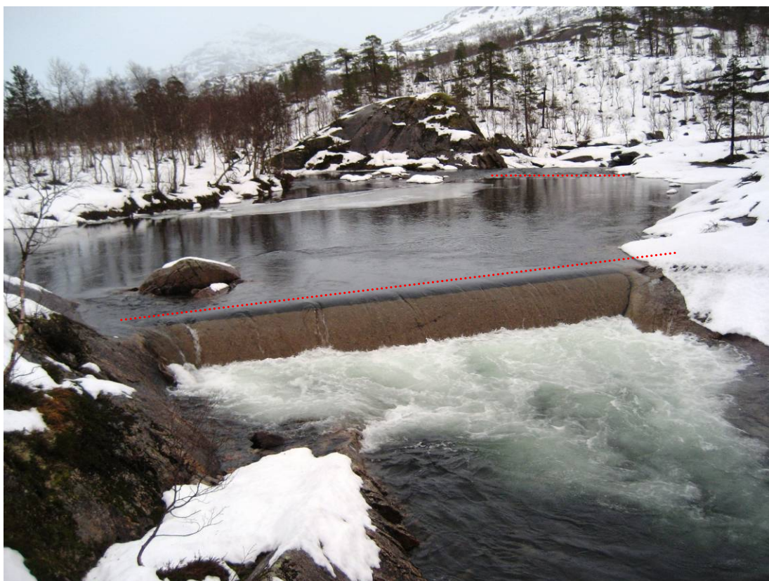
Bilde 4: Eksisterende betongterskler ved inntaksområdet.
