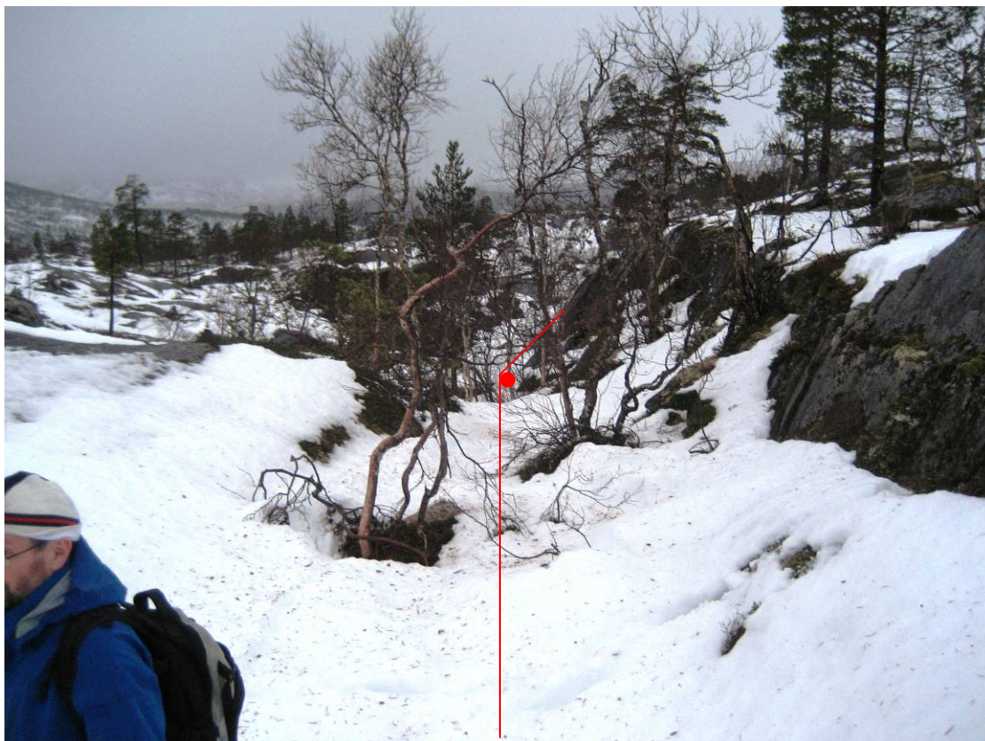
Bilde 7: Rørgate sett medstrøms fra samme punkt som forrige bilde. Rød prikk på detet og neste bilde er samme punkt.
