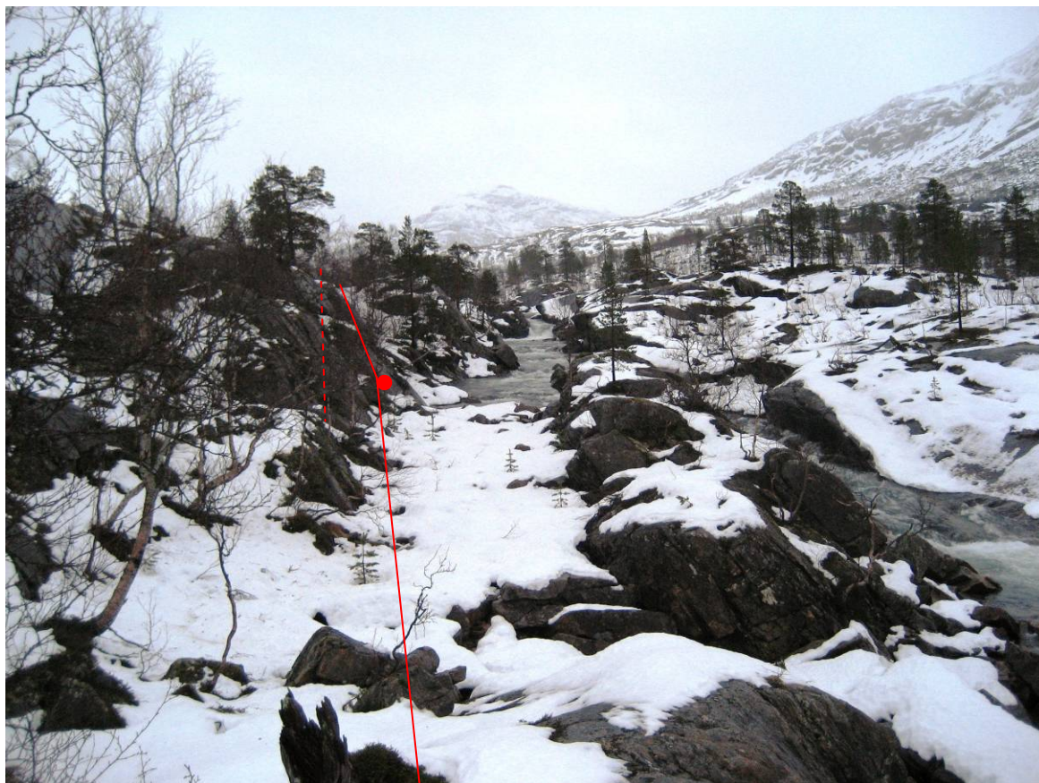
Bilde 8: Sett motstrøms fra sving i vestre grein. Rørgata er merket med rød strek. Rød stiplet linje markerer hvor en skjæring kan sprenges ut. Massene brukes til forbygning mot elva.
