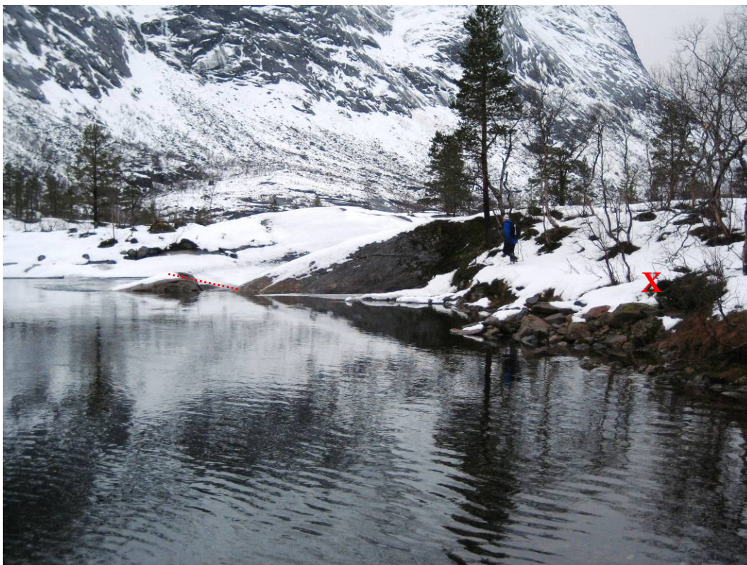
Bilde 3: Nærbilde av inntaksområdet. Plassering av inntak merka med rødt kryss. Eksisterende betongterskel merka med rød stipla linje. Se neste bilde.
