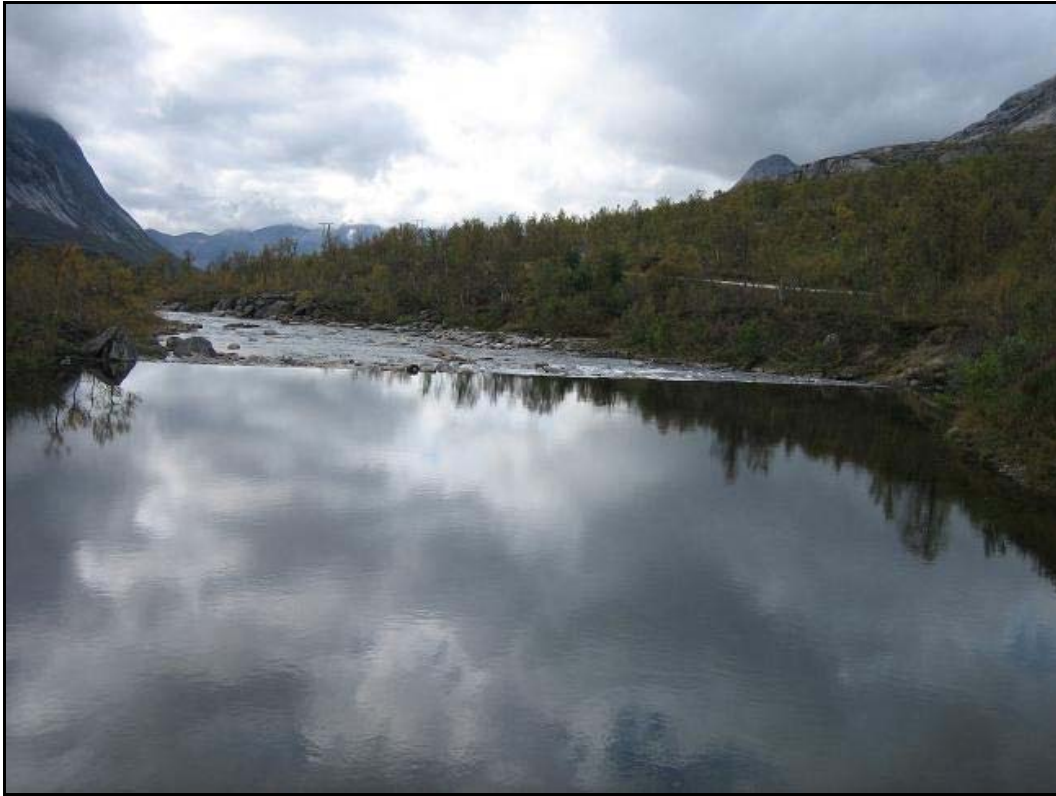
Foto 3: Like nedstrøms brua er det etablert en steinterskel i elva. Denne terskelen er et naturforbedrende tiltak, etter Kobbelv – utbyggingen, og danner et stilleflytende vannspeil i elva.
