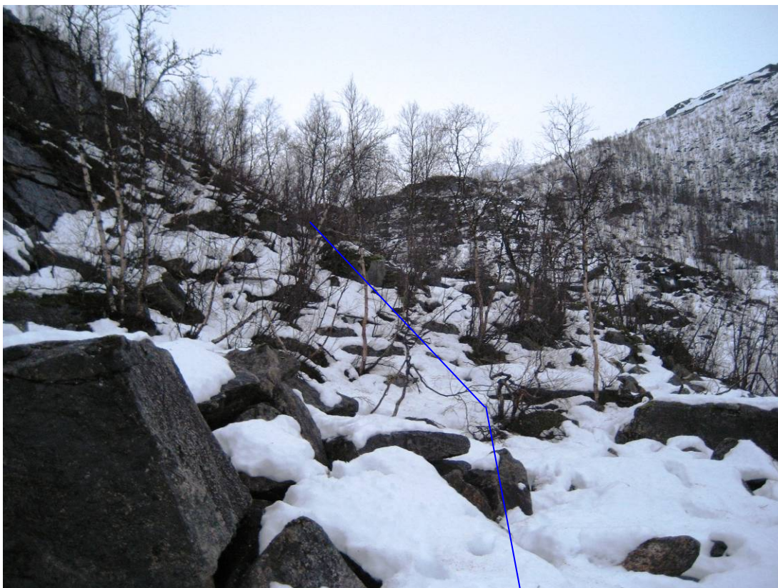
Bilde 10: Rørgata sett motstrøms. Nedgravd rørgate markert med blå heltrukket linje.
