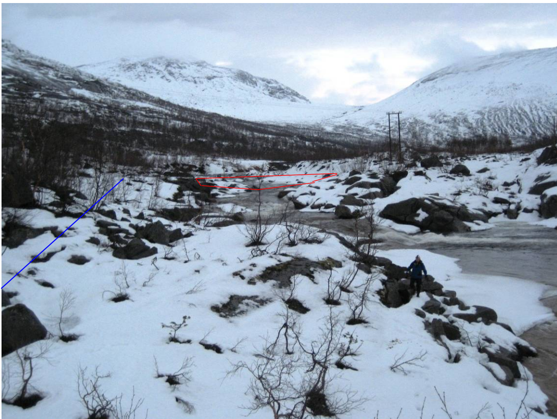
Bilde 6: Gjerdalselva sett motstrøms. Planlagt inntaksdam er antydnet med rød heltrukket linje. Nedgravd rørgate er merket med blå heltrukket linje.
