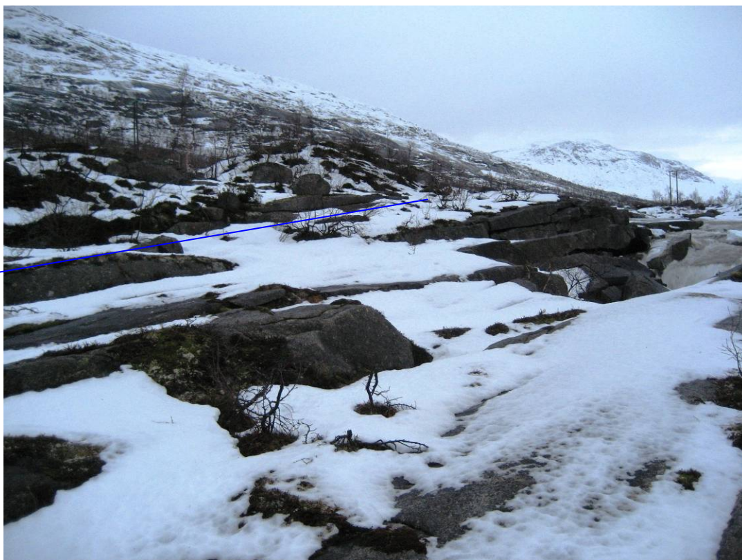
Bilde 8: Rørgata sett motstrøms. Nedgravd rørgate markert med blå heltrukket linje.
