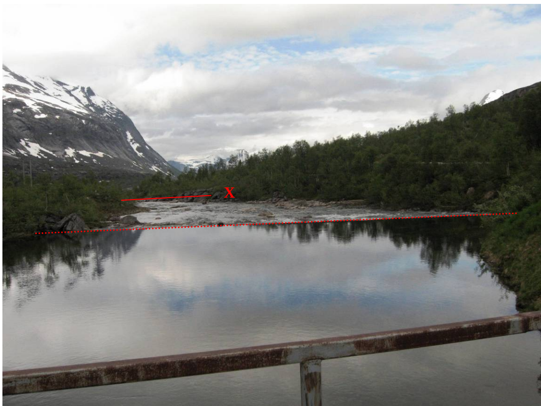
Bilde 2: Stillelva/Gjerdalselva sett medstrøms fra bru oppstrøms inntak. Eksisterende terskel er vist med stiplest rød linje. Planlagt dam er vist med heltrukket rød strek. Planlagt inntaksplassering er vist med rød X.
