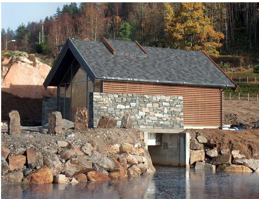
Bilde: Nybygd anlegg tilsvarende planlagt stasjon i Kalvebakkkelva.
