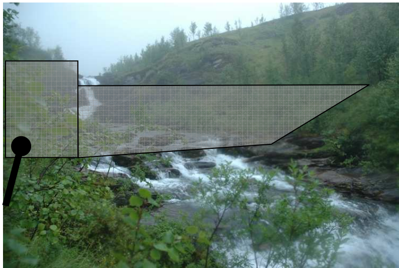
Aktuelt inntaksområde med inntaksdam omtrentlig inntegnet
