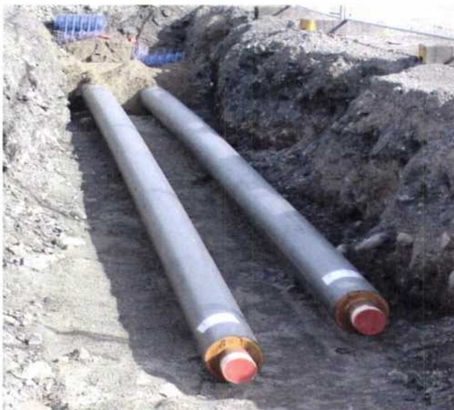
Figur 4-2, Fjernvarmerør fra bygging
