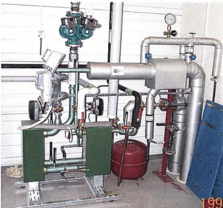
Figur 3-2, Eksempel på kundesentral med vekslere for varmt tappevann og oppvarming.
