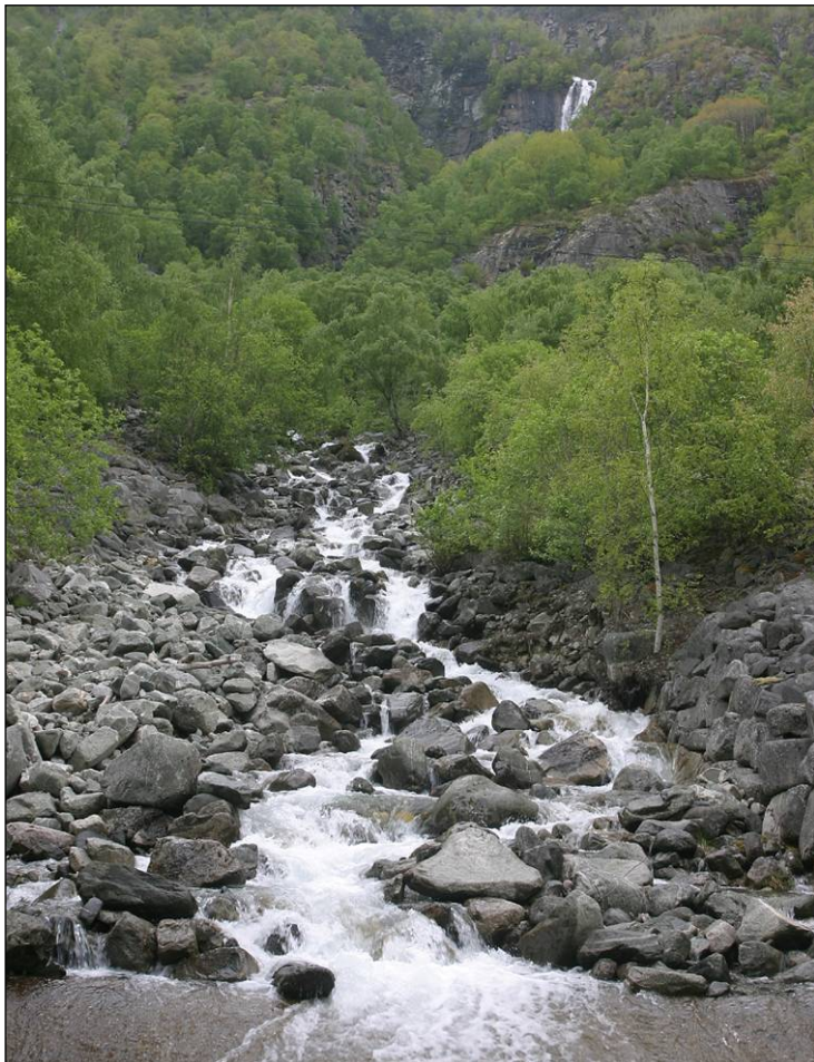
Figur 5. Jutlaelvi sett fra E16. Oppvandring av fisk fra Lærdals-elva er ikke mulig pga betongsålen under brua. Forholdene for fisk og andre ferskvannsorganismer er dårlige.
