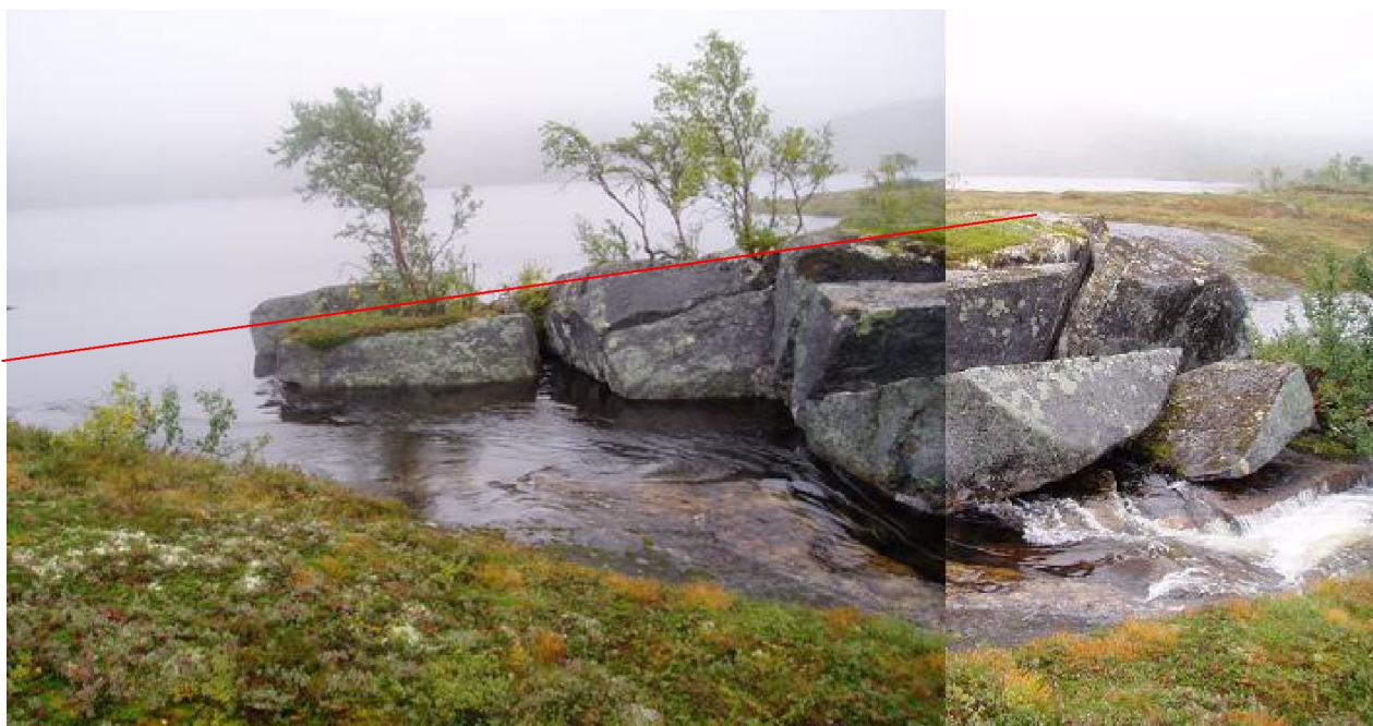
Bilde 7 Utløpet av Tennvatnet. Toppen på sprengsteinsfylling er markert med rød strek.
