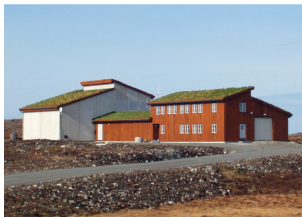
Figur 6.4 Transformatorstasjon og driftsbygg (eksempel fra Smøla vindpark)
