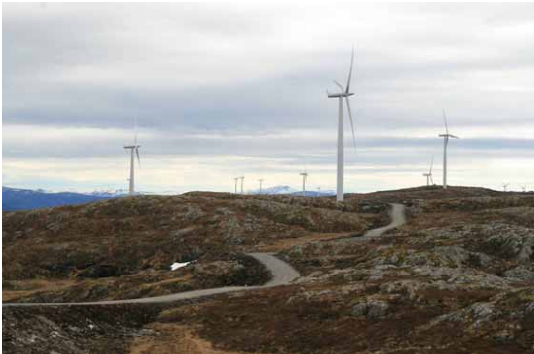
Figur 4.19: Interne veier i Hitra vindpark. Foto: Trond Simensen.
