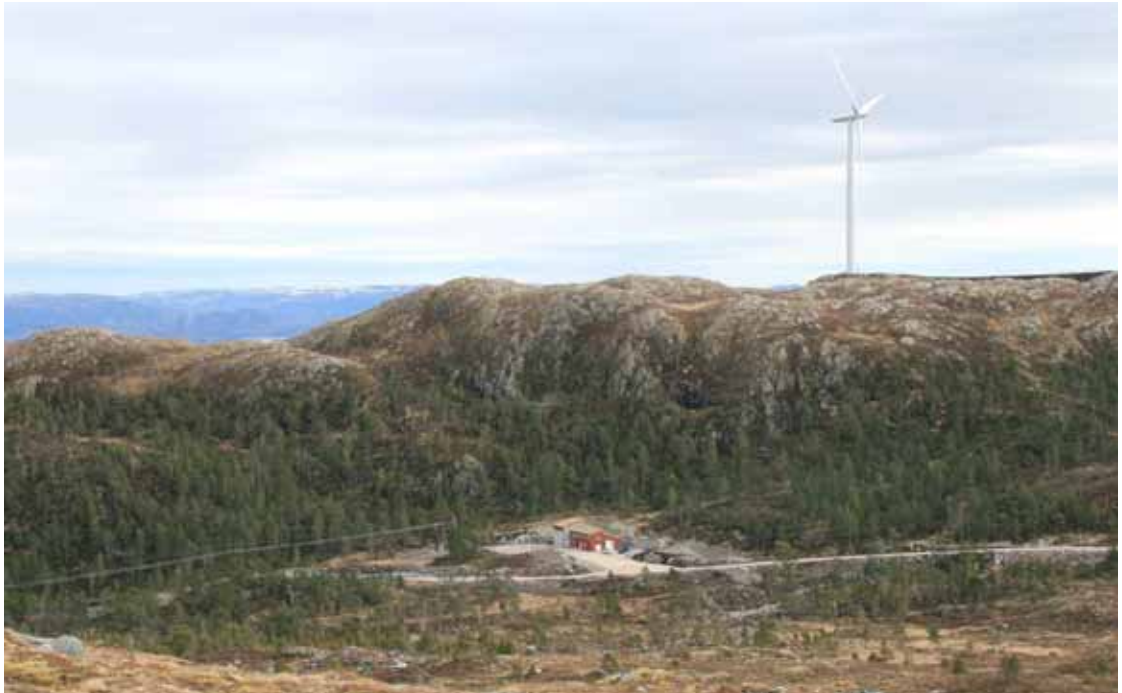
Figur 4.20: Atkomstvei og transformatorstasjon i Hitra vindpark. Eksempel på en typisk transformatorstasjon for en vindpark i lågfjellet. Foto: Trond Simensen
