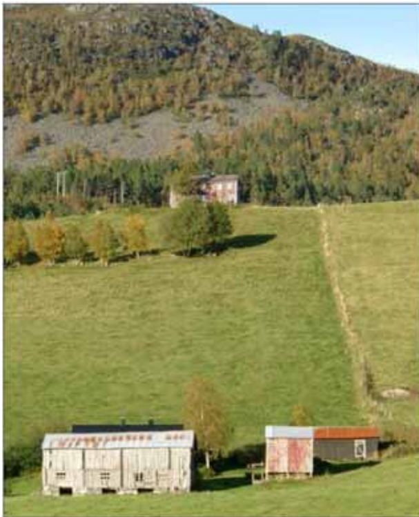
Figur 5.7. Østråkern er det best bevarte tunet i Området. Fjøset er bygd med svalgang på oversiden.
