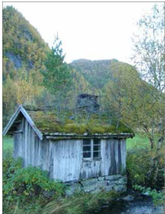
Figur 5.8. På gården Aunan i Vuttudalen står ei gammel smie. Bygningen er godt synlig fra vegen, og er et viktig element i landskapet her.
