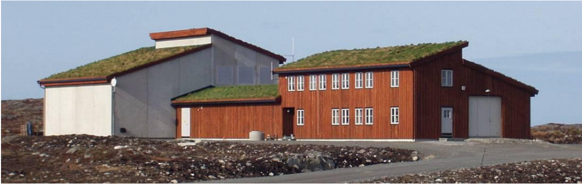
Figur 4.15. Eksempel på 132/33 kV trafotrafostasjon i parken (bildet viser Smøla trafostasjon og er kun ment som illustrasjon)
