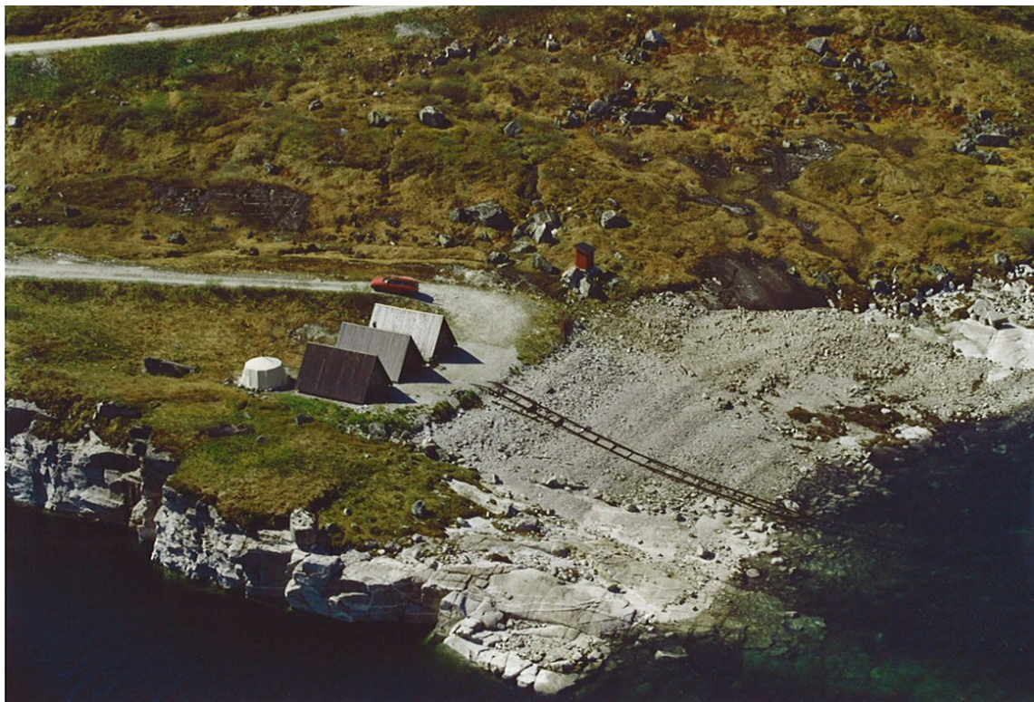
Figur 6.16 Naustene sett ved lav vannstand i Øvre Kalvatnet. Vannet er tappet ned ca. 10 meter. Vannet har en reguleringshøyde på 35 m. Foto: Frithjof Plathe.
