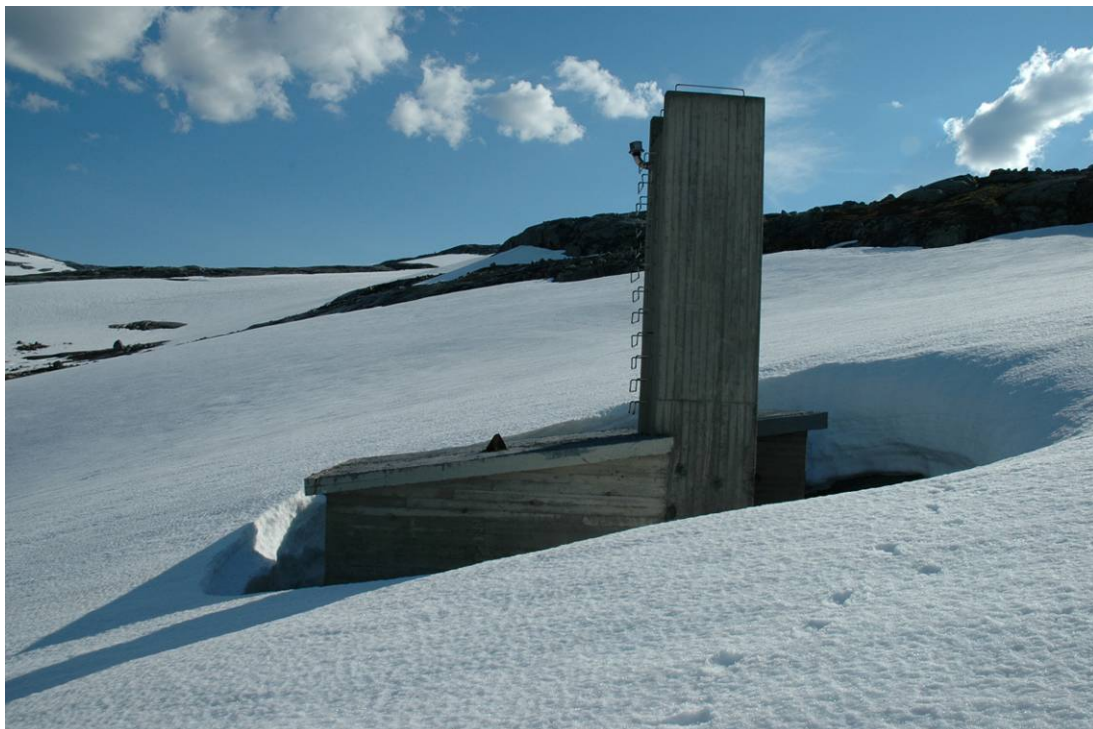
Figur 5.8 Tappelukehus for overføringen fra Kalvatet til Nilsinetjørnin. Foto: Christine R. Wist, SWECO Grøner
