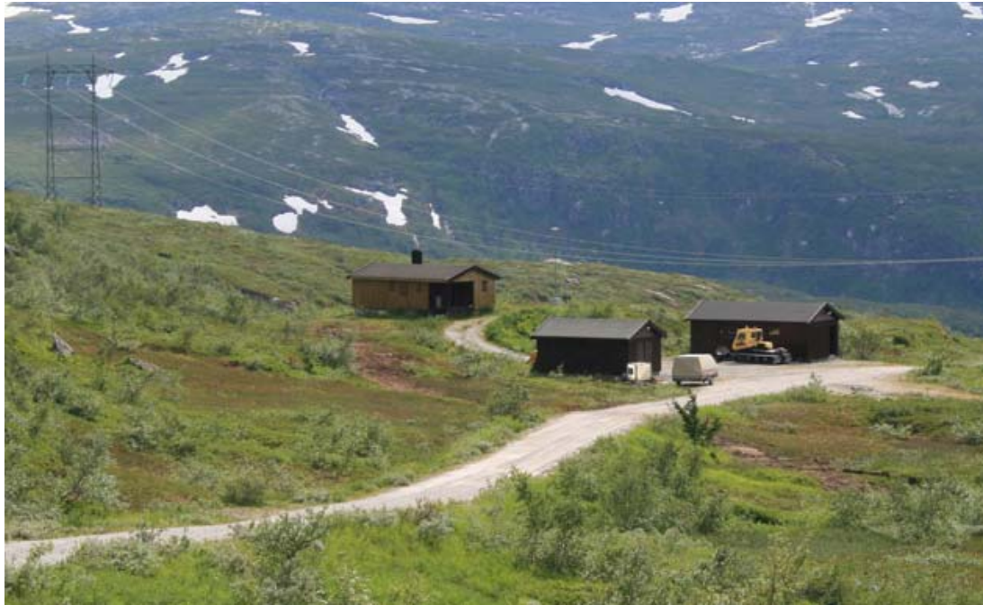
Figur 5.7 Driftsygninger for NTE (Nord-Trøndelag Elektrisitetsverk) ved øvre Kalvatn med kraftledningen i bakgrunnen. Foto: Line Merete Valle, SWECO Grøner
