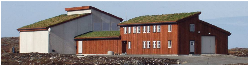
Figur 4-4. Eksempel på 300 kV trafostasjon i parken (bildet viser Smøla trafostasjon).
