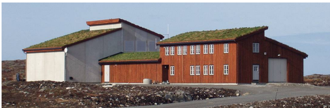
Figur 4.4. Eksempel på 300 kV trafostasjon i parken (bildet viser Smøla trafostasjon).
