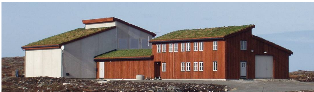
Figur 4-4. Eksempel på 300 kV trafostasjon i parken (bildet viser Smøla trafostasjon).
