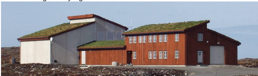
Figur 4. Eksempel på 300 kV trafostasjon i parken (bildet viser Smøla trafostasjon).
