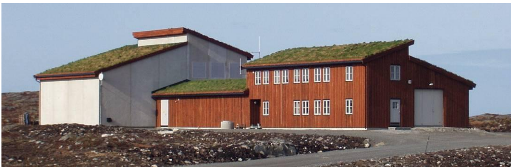
Figur 6 Eksempel på 300 kV trafostasjon i parken (bildet viser Smøla trafostasjon).
