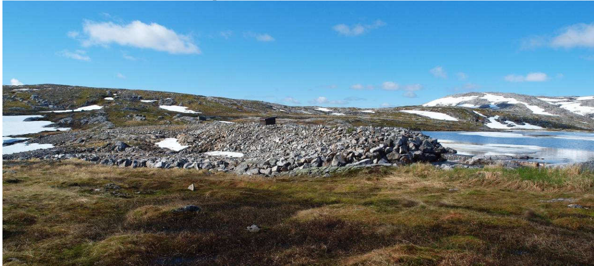
Figur 4.2. Dam ved Øvre Ringvatnet.
